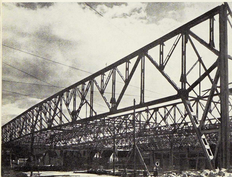
Fig. 503. Vue d'un portique de 70 mètres après montage.
