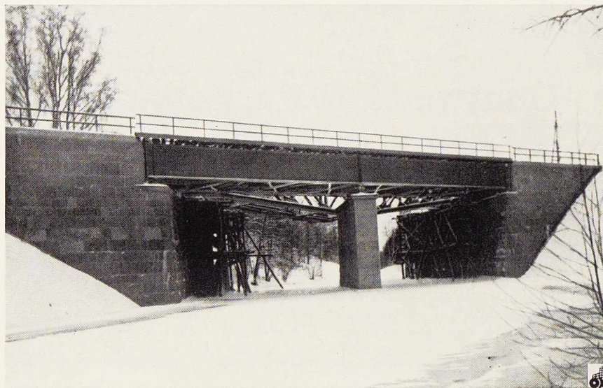
Fig. 329. Vue de l'ouvrage en cours de construction.
