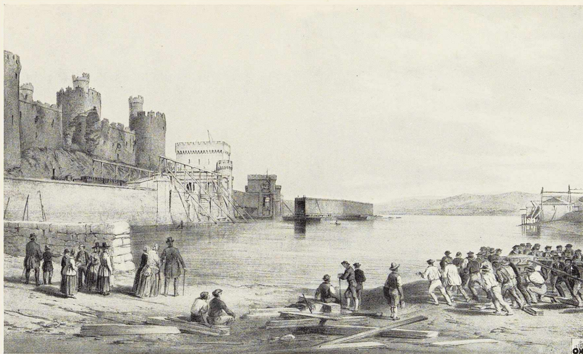
Fig. 321. Transport par flottage du pont de Conway pesant 1 522 tonnes.
