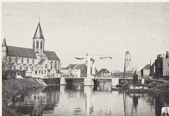
Fig. 372. Pont-levis sur la Lys à Deynze en cours de montage.
