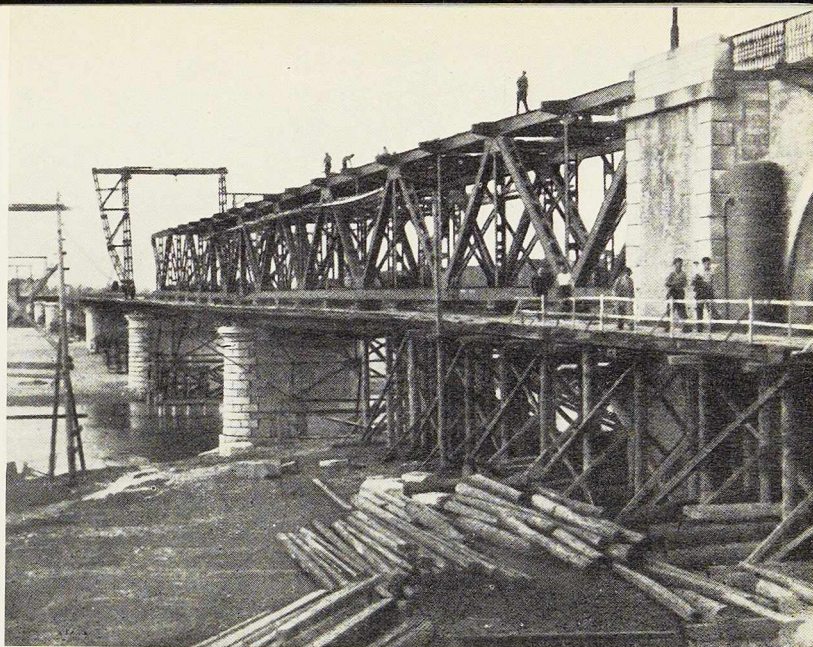
Fig. 342. Montage d'une travée du nouveau pont.
