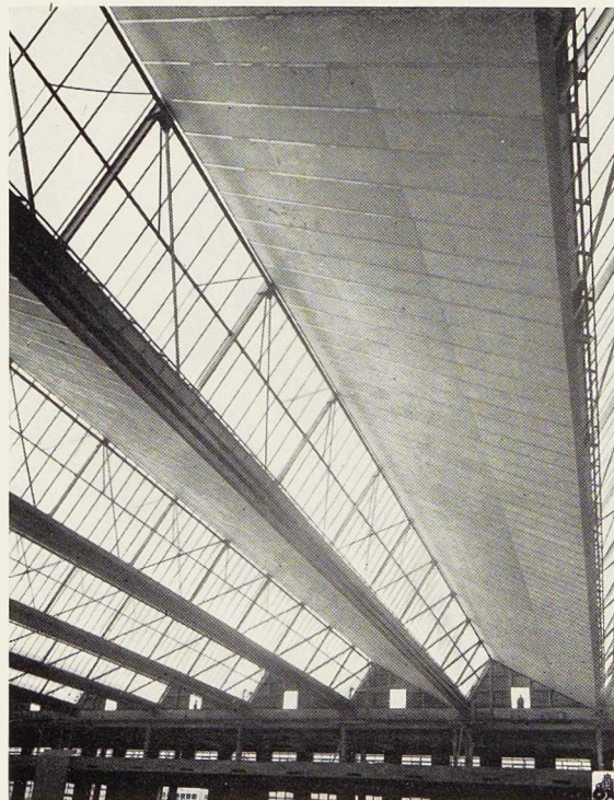
Fig. 175. Vue intérieure du hall montrant les versants vitrés et la sous-toiture en plaques planes en fibro-ciment.
