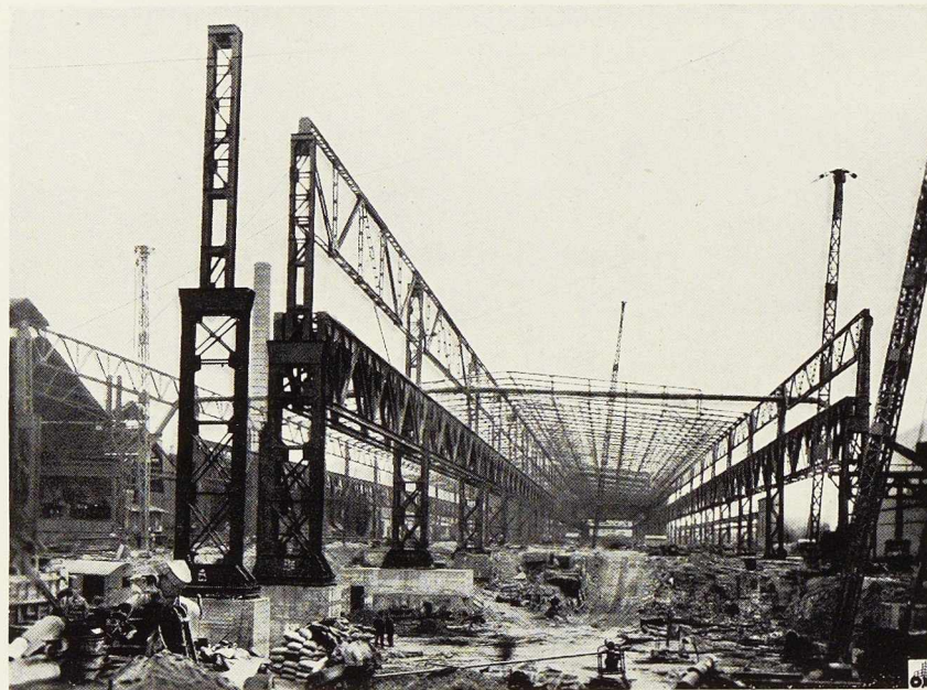
Fig. 19. Vue de la charpente des halls de laminoir.
