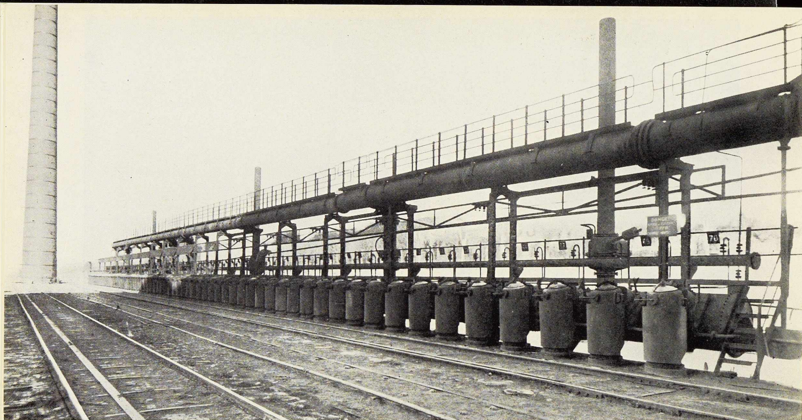
Batterie Lecoq de 70 fours, mise en service en 1949.
