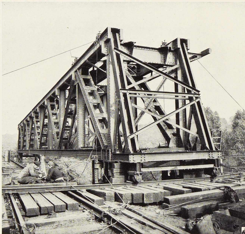
Fig. 31. Vue du pont de la Planchette en cours de montage.
