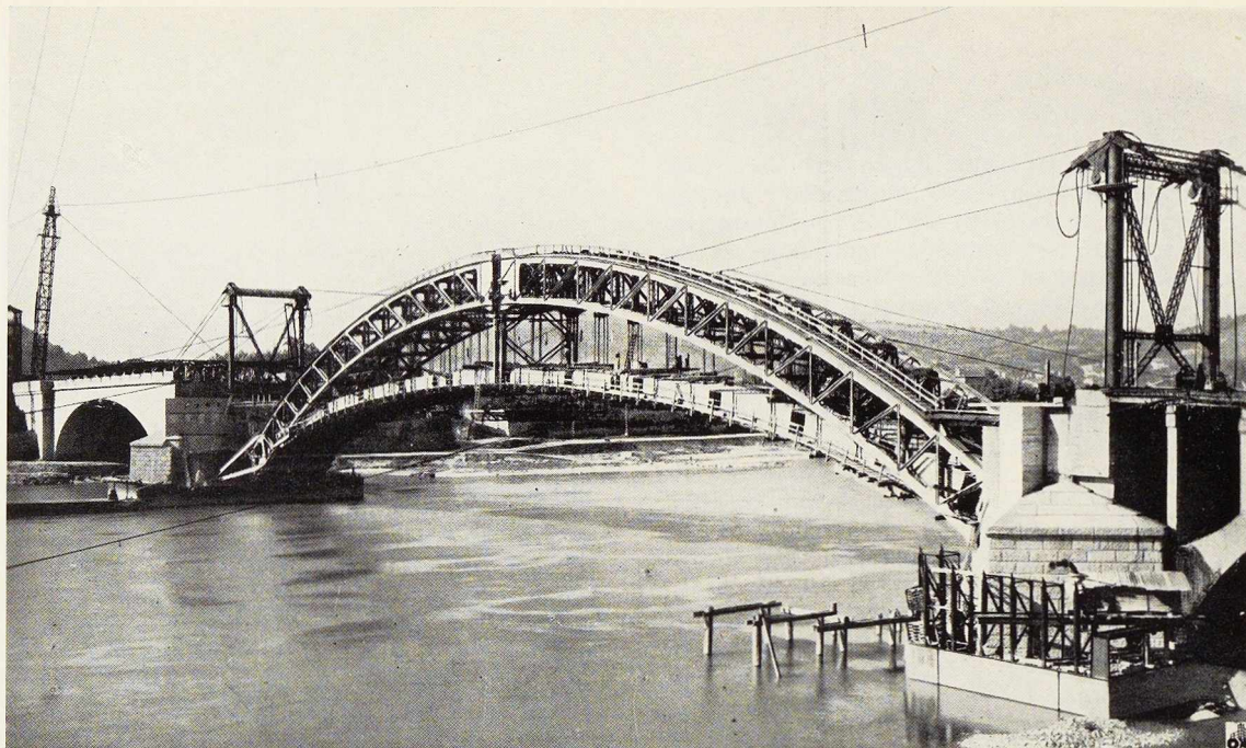
Fig. 64. Cintre métallique du pont sur le Rhône à Vienne (France) construit par la Société Schneider et C ie . La portée de l'arc principal est de 108 mètres.
