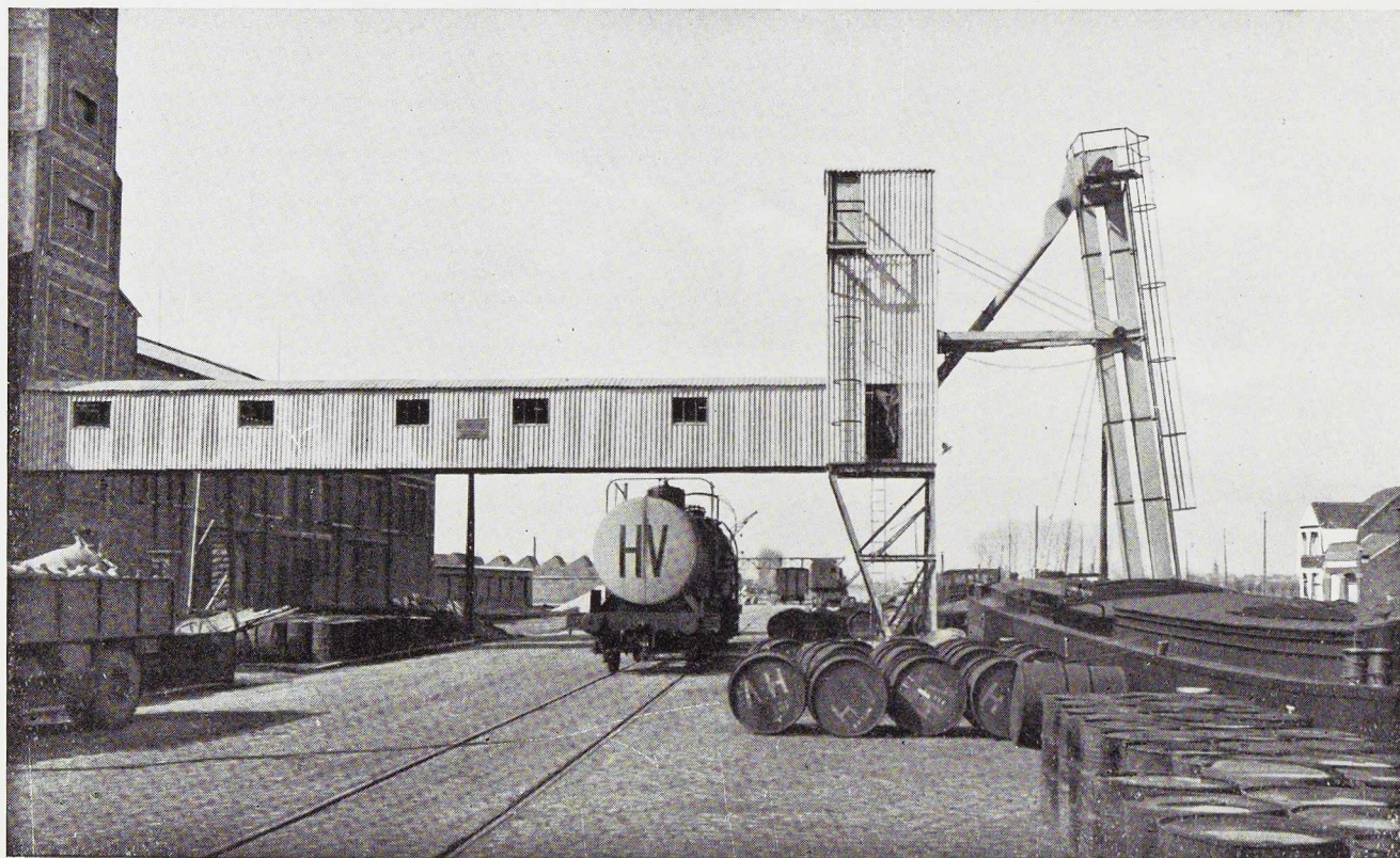
Installation de déchargement de bateaux par élévateur à godets, goulotte et transporteur à courroies. A l'intérieur du bâtiment, installation de stockage en silos.
