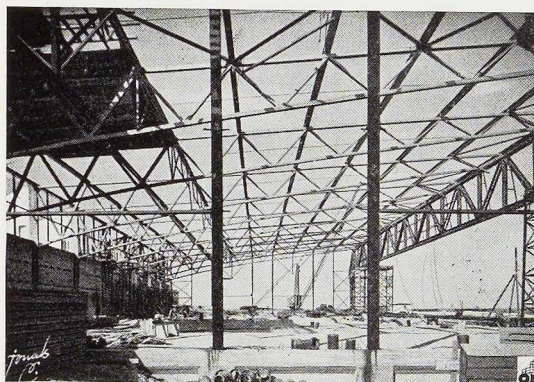
Fig. 786. Hangar n° 2. Vue des poutres transversales.
