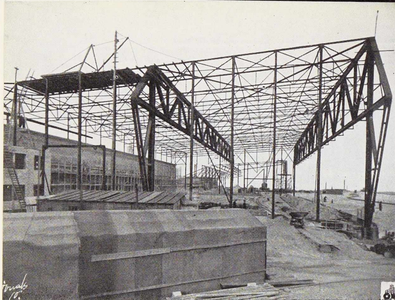
Fig. 788. Ossature métallique du hangar n° 1.
