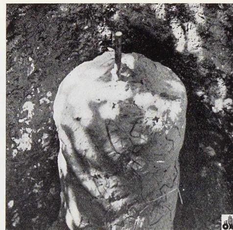
Fig. 782. Electrode en magnésium avec « Back-fill ».
