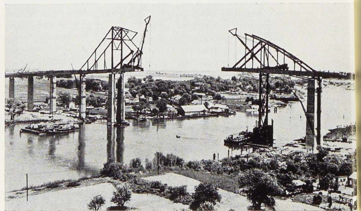
Fig. 734. Vue du pont en cours de montage.
