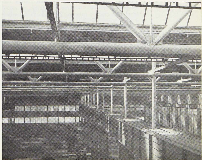
Fig. 732. Détails des fermes en treillis tubulaire.
