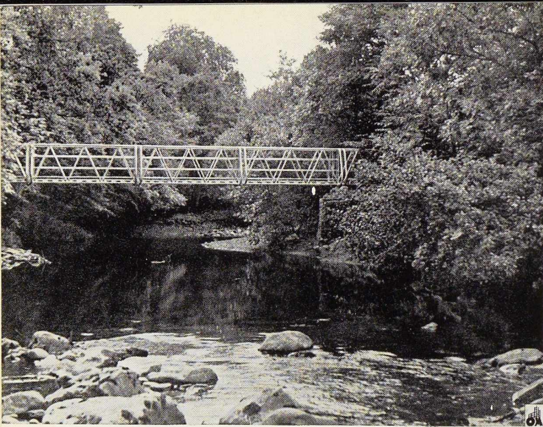
Fig. 604. Passerelle en tubes d'acier en Angleterre. Photo R. W. Brown.
