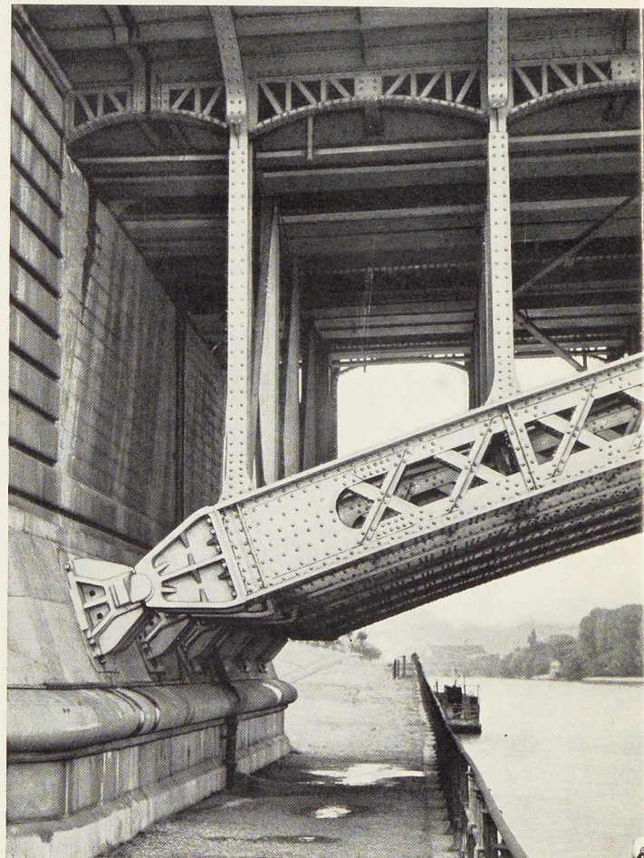
Fig. 541. Détail montrant la retombée de la travée de rive, côté Liège.
