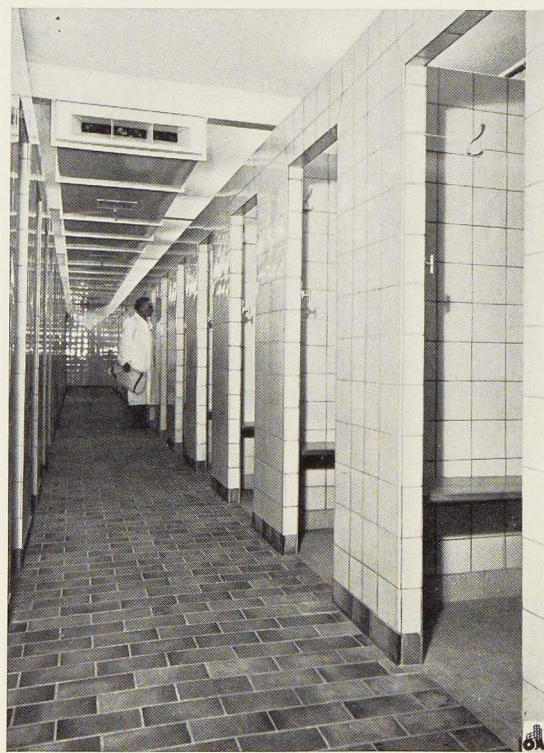
Fig. 588. Installations sanitaires modernes aux usines Brown-Boveri à Baden.
