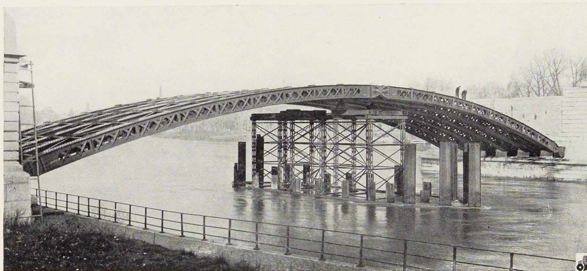
Fig. 552. Vue des arcs à trois rotules d'une travée de rive du pont de Fragnée sur la Meuse. La portée des travées de rive est de 53 m 775.
