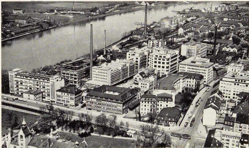
Fig. 592. Vue aérienne du vaste complexe formé par les bâtiments des usines chimiques C. I. B. A. à Bâle.
