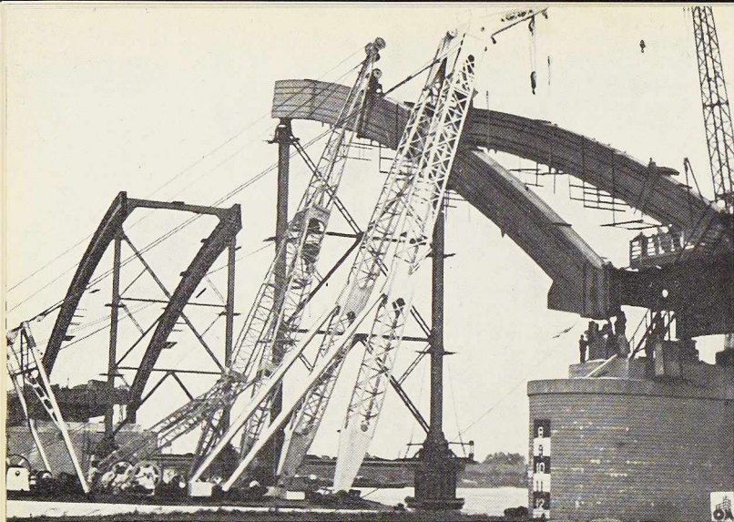
Fig. 573. Mise en place du dernier tronçon d'extrémité des arcs.
