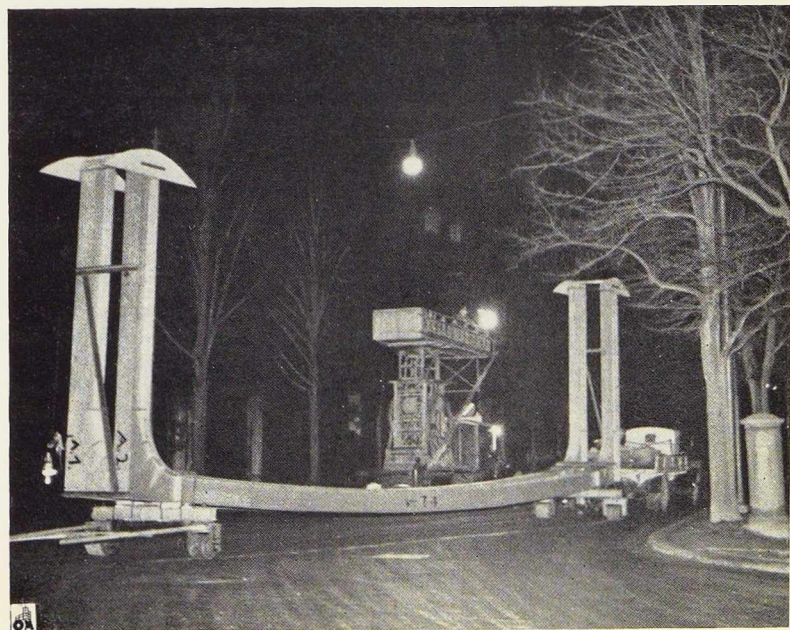
Fig. 419. Transport nocturne d'un portique complètement monté en atelier.
