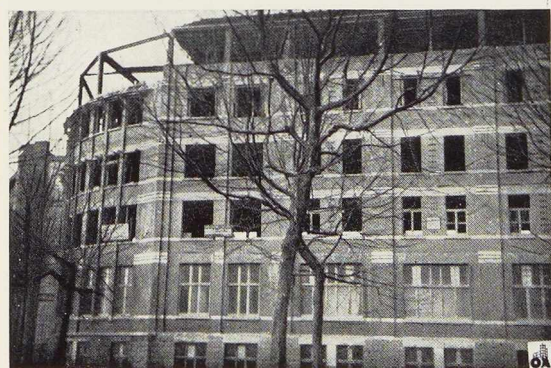
Fig. 381. Vue du bâtiment : façade principale en voie d'achèvement.
