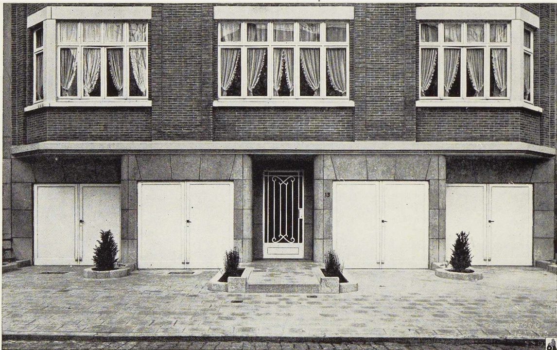
Fig. 349. Portes métalliques de garage dans un immeuble à appartements.
