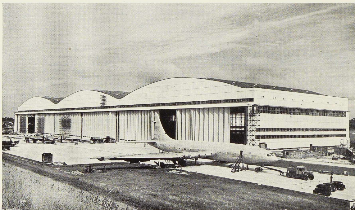
Fig. 294. Vue d'ensemble du hangar construit pour abriter l'avion géant Bristol-Brabazon I. Photos Bristol Aeroplane C o Ltd.
