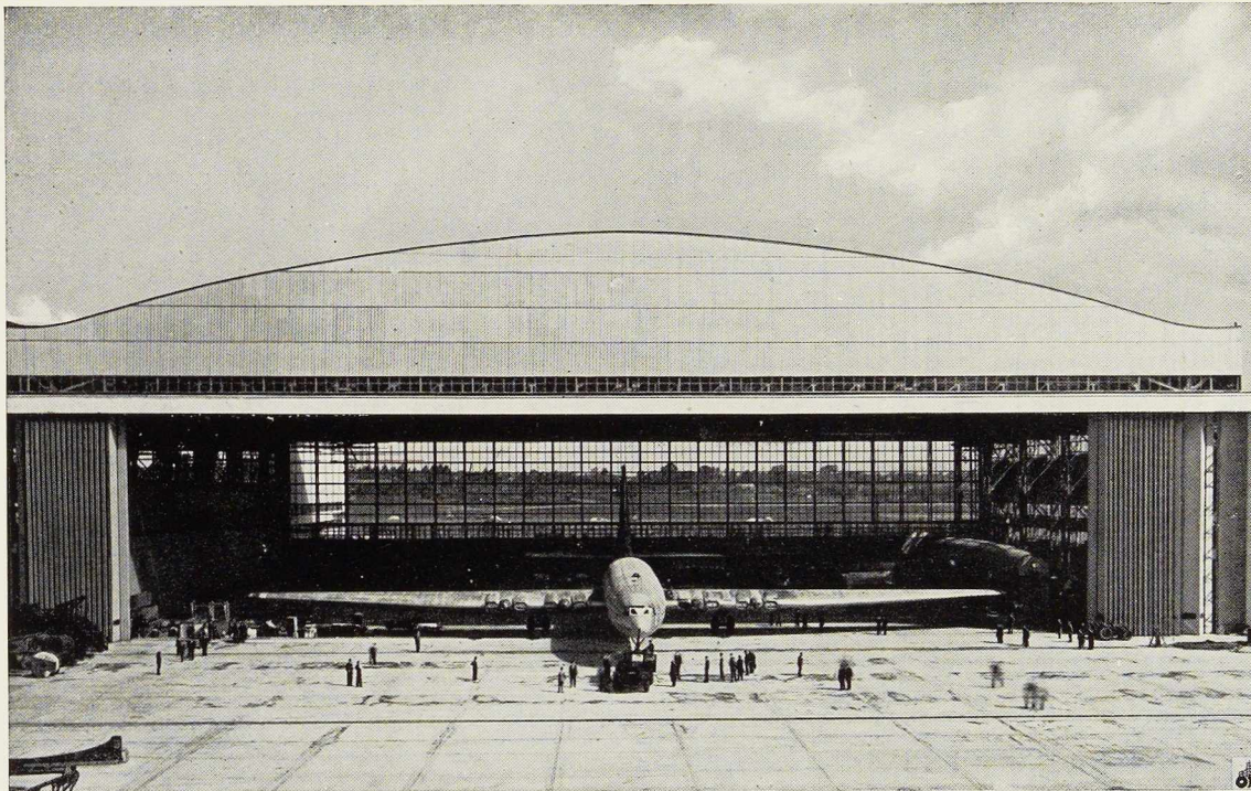
Fig. 295. Vue du hangar d'aviation de Filton près de Bristol, les grandes portes repliées en accordéon. A l'intérieur, l'avion Bristol-Brabazon I dont l'envergure des ailes atteint 70 mètres.
