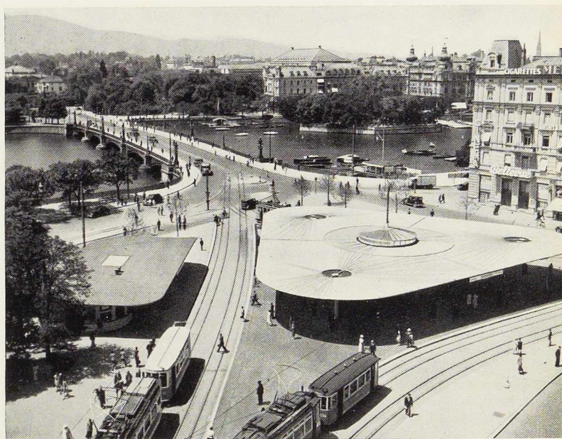
Fig. 367. Auvent de la place Belle-Vue à Zurich.
