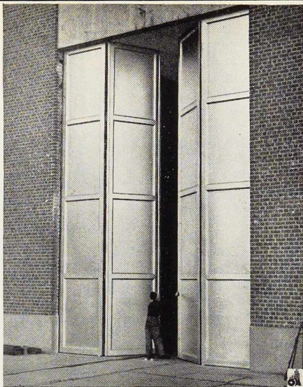
Fig. 344 à 346. Portes accordéons, porte pivotante et porte basculante. Constructeur : Ateliers Vanderplanck, Fayt-lez-Manage.
