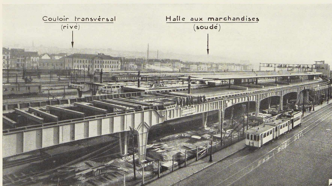
Fig. 239. Voies à quai de la nouvelle gare surélevée de Bruxelles-Midi établies sur une charpente en acier. L'espace sous voies est utilisé comme couloir d'accès aux quais (à gauche) ainsi que comme halle aux marchandises (à droite).
