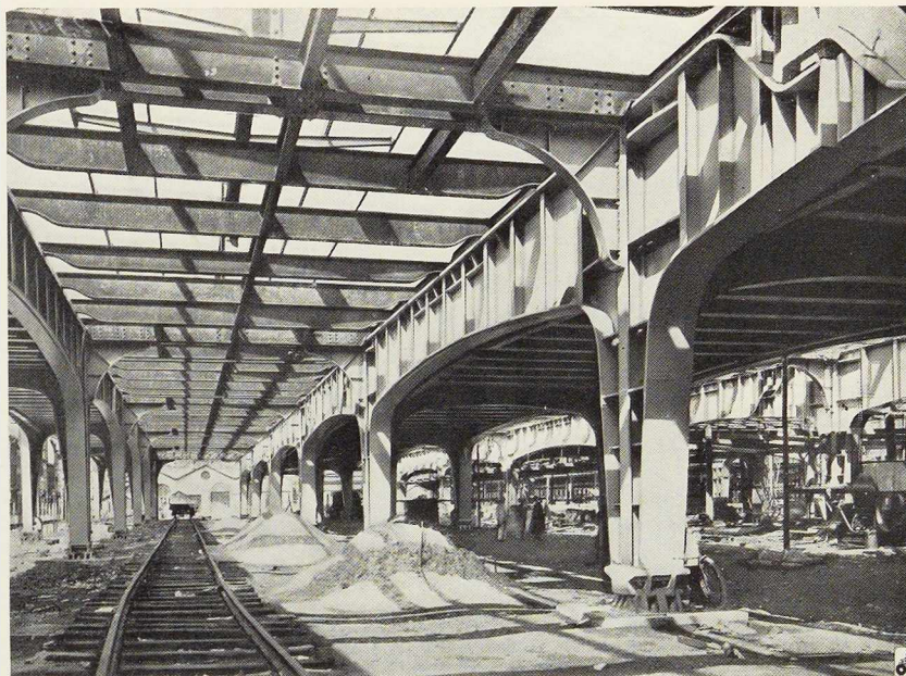
Fig. 247. Vue intérieure de la charpente de la halle aux marchandises sous voies de la nouvelle gare du Midi à Bruxelles.
