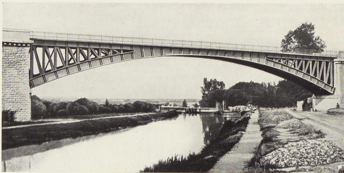
Fig. 277. Viaduc de Pont-aux-Moines près d'Orléans (France). Les arcs à deux articulations ont une portée de 50 mètres. Constructeurs : Etabl. Bordeaux-Sud.
