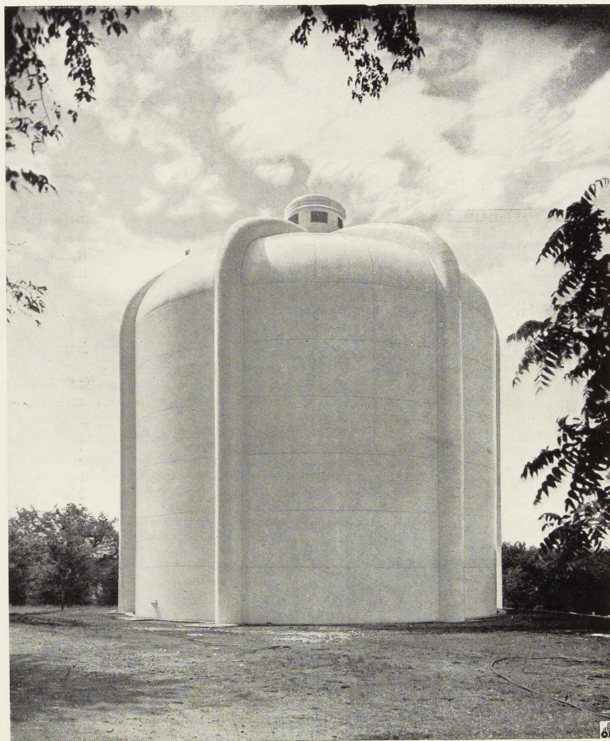
Réservoir métallique soudé de 5 000 m 3 érigé par la Chicago Bridge & Iron Company pour la Ville de Manhattan, dans le Kansas (U. S. A.).
