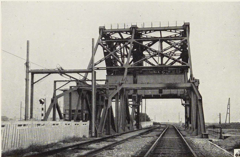
Fig. 112. Vue d'enfilade du nouveau pont basculant.
