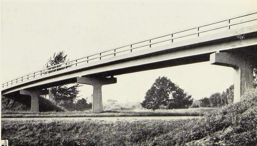
Fig. 97. Passage inférieur de l'Old Alfred Road. La portée des travées est de 17 m 85. Ingénieurs-conseils : Howard, Needles, Tammen & Bergendoff. Constructeur : American Bridge Company.
