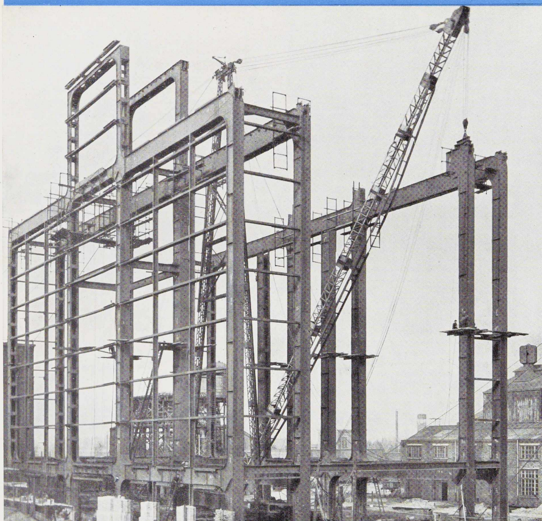
VUE DE L'OSSATURE MÉTALLIQUE DE LA CENTRALE DE LANGERBRUGGE EN COURS DE MONTAGE
