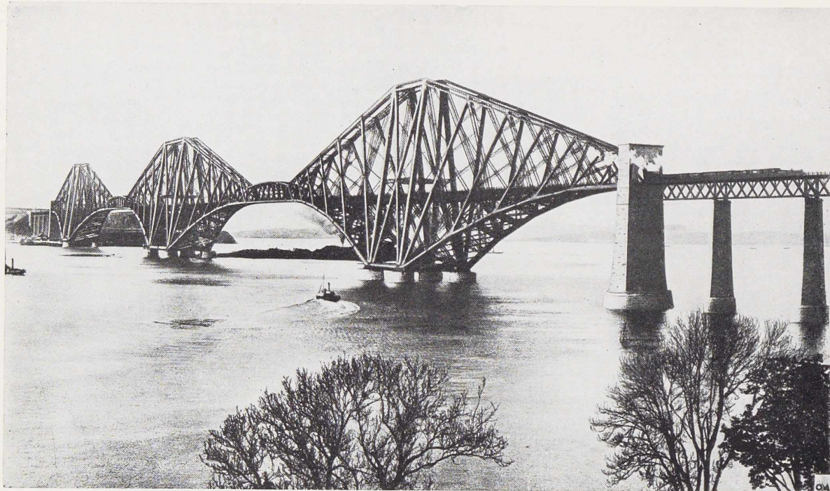
Fig. 28. Vue générale du pont-rails sur le Forth en Ecosse. Construit il y a un demi-siècle, cet ouvrage, du type Cantilever, a une longueur totale de 1 630 mètres.
