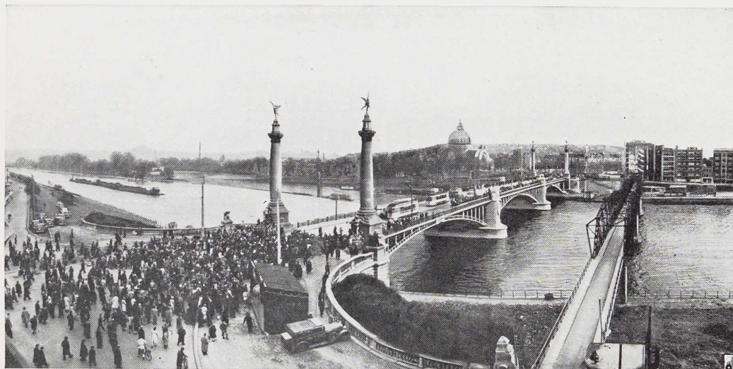
Fig. 32. Vue du pont de Fragnée à Liège, prise le jour de son inauguration par le Ministre des Travaux Publics. L'ouvrage comporte trois traverses en arc à 3 articulations de 53^m725 , 57^m75 et 53^m725 de portée respectivement.
