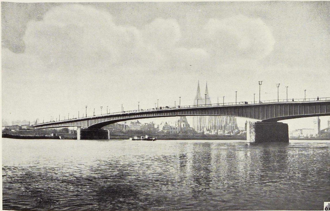
Fig. 797. Vue du nouveau pont de Cologne-Deutz sur le Rhin.
