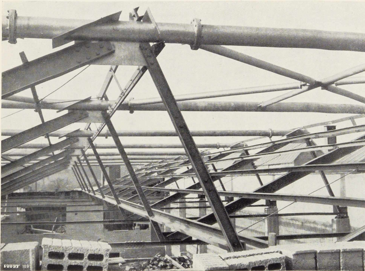
Fig. 760. Vue de la charpente métallique en cours de montage. Cliché Bulletin Technique Vevey.
