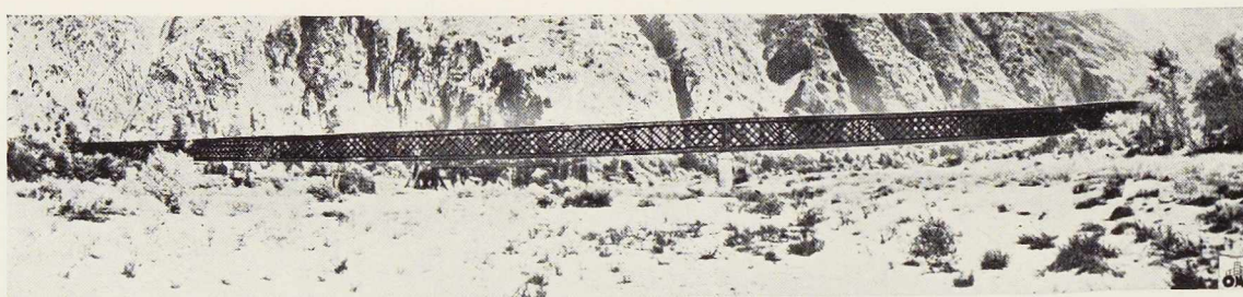
Fig. 764. Vue générale du pont sur le Toce après sa reconstruction.
