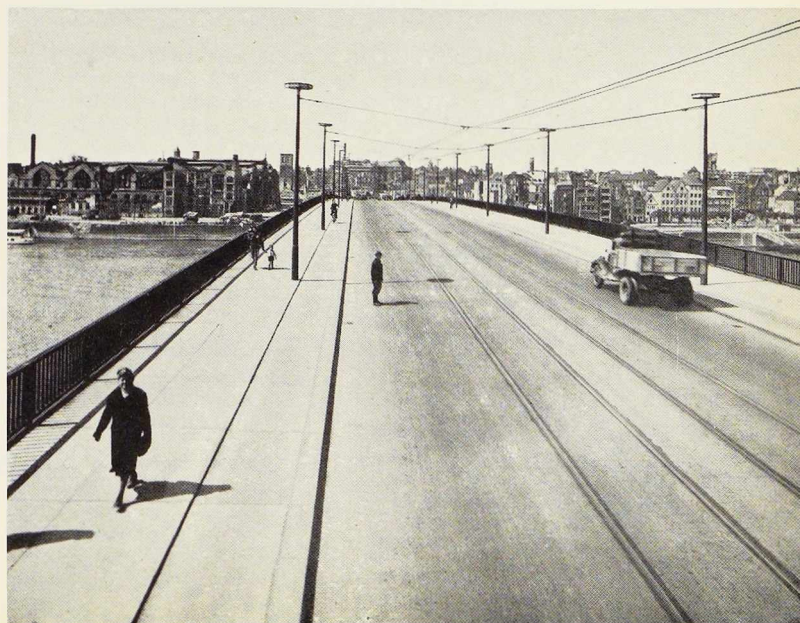
Fig. 816. Vue d'enfilade du pont achevé.
