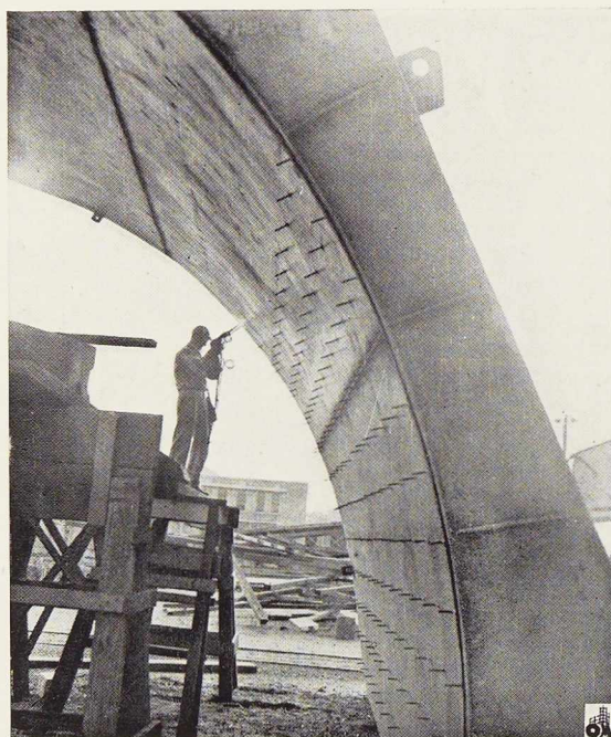
Fig. 648. Tube intérieur du tunnel garni de goujons soudés destinés à assurer la liaison avec le revêtement intérieur en béton.
