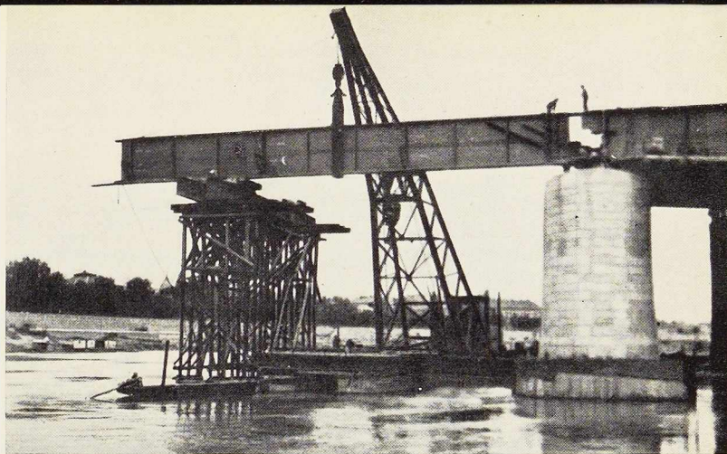
Fig. 631. Mise en place des tronçons de la poutre de rigidité.
