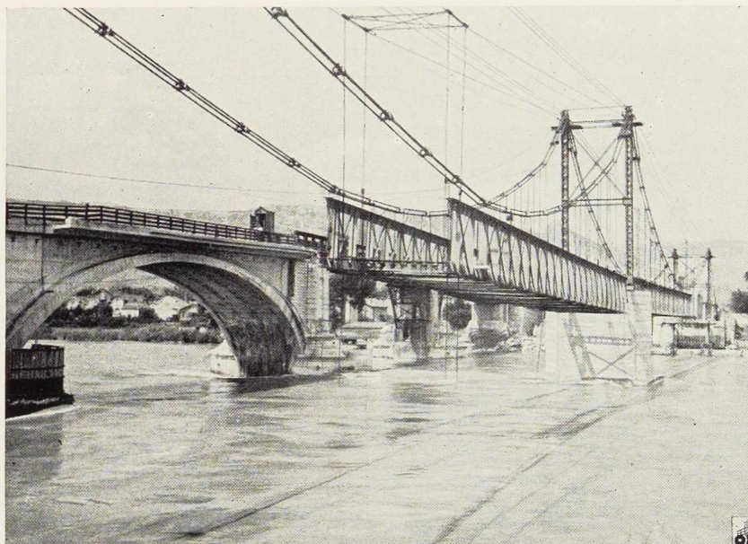
Fig. 658. Pont roulant aérien utilisé pour le montage du tablier.
