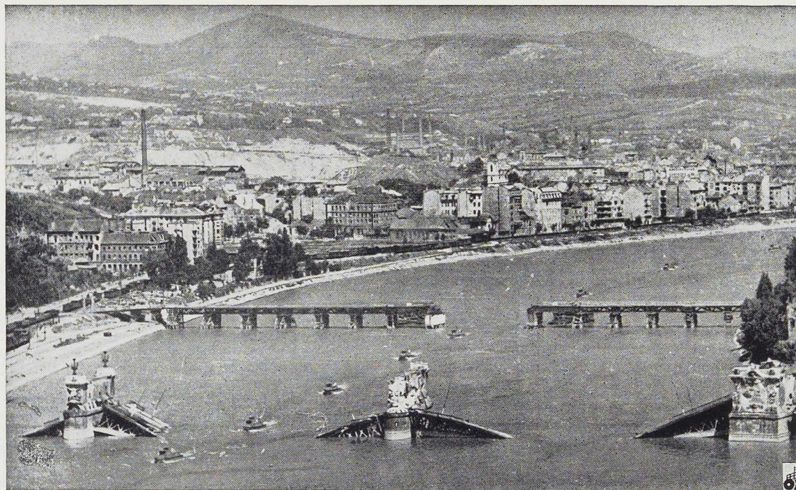
Fig. 517. Vue générale du pont Marguerite après sa destruction au cours de la deuxième guerre mondiale.
