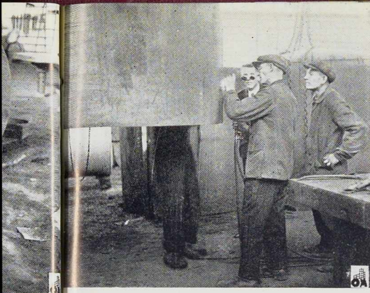
Fig. 542. Soudure longitudinale à double cordon « B ».
