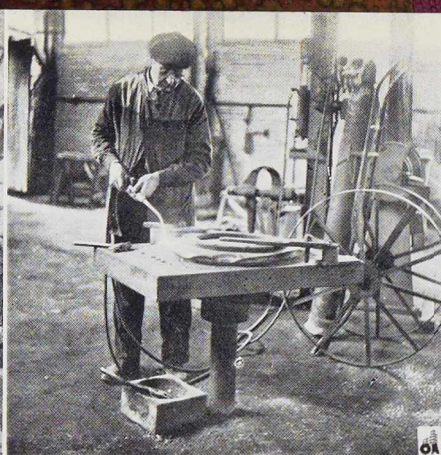
Fig. 558. Formage au chalumeau de fonds à bords tombés.
