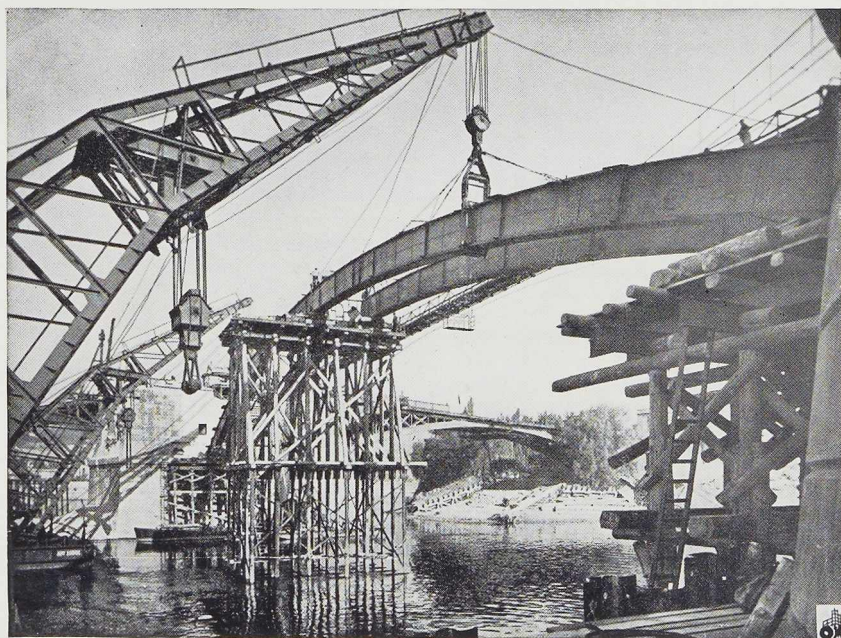
Fig. 523. Assemblage des arcs sur la rive.
