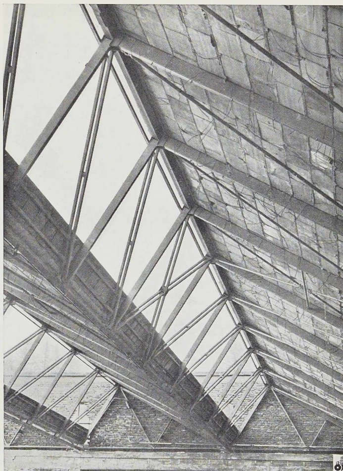
Fig. 581. Vue intérieure de la couverture en shed réalisée en construction tubulaire.
