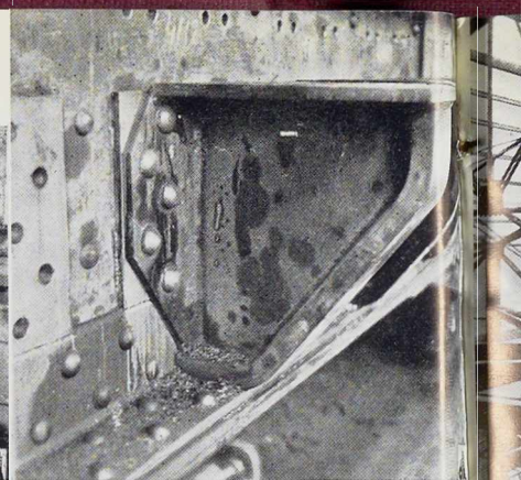
Fig. 553. Console oxycoupée et soudée d'une charpente.
