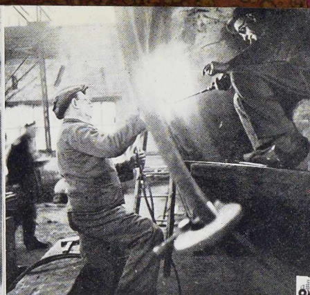
Fig. 540. Soudure montante à double cordon « B ».
