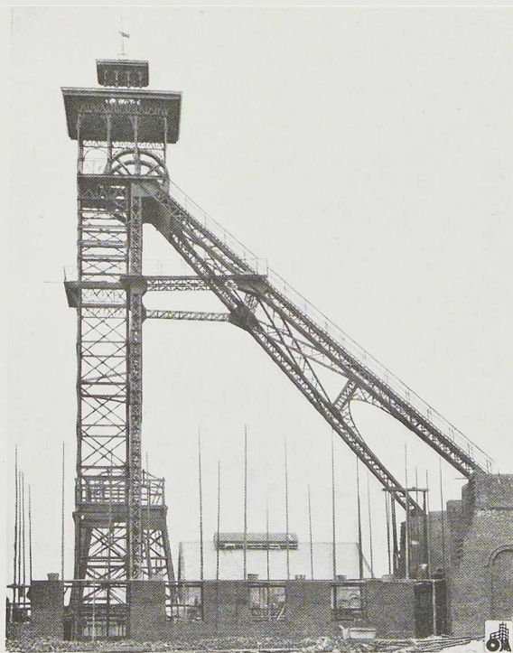
Fig. 464. Ensemble d'un chevalement construit en 1915 par la S. A. Brugeoise et Nicaise & Delcuve. La hauteur de la recette est de 30 mètres. Les molettes sont en acier coulé pour câble plat en acier.
