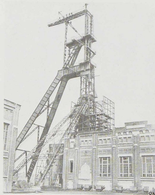
Fig. 474. Chevalement soudé construit en 1946 par les Ateliers de Construction de Jambes au puits Marie-José de la S. A. des Charbonnages de Mauraige.
