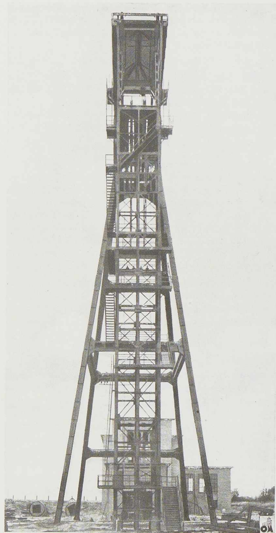
Fig. 473. Chevalement soudé construit en 1939 par les Ateliers de Construction de Jambes pour les Houillères d'Anderlues.
