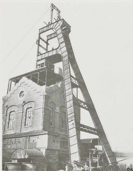
Fig. 475. Ensemble du chevalement construit et monté par la S.A. Baume et Marpent en vue de la modernisation du puits n° 1 du siège Saint-Arthur de la S.A. des Charbonnages de Mariemont-Bascoup.
