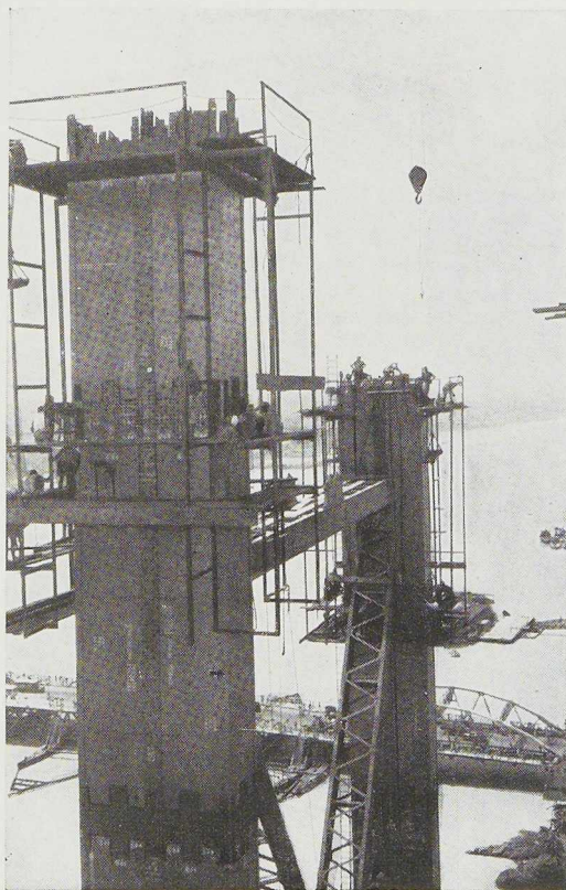
Fig. 456. Construction du pylône côté Howrah.
