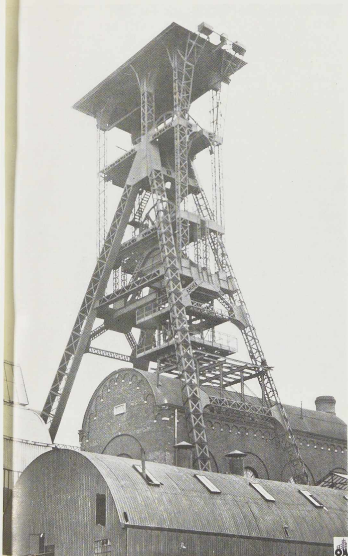
Fig. 472. Chevalement construit en 1939 par la S. A. Baume et Marpent pour le puits n° 1 du siège n° 5 de la S. A. des Charbonnages de Mariemont-Bascoup.
