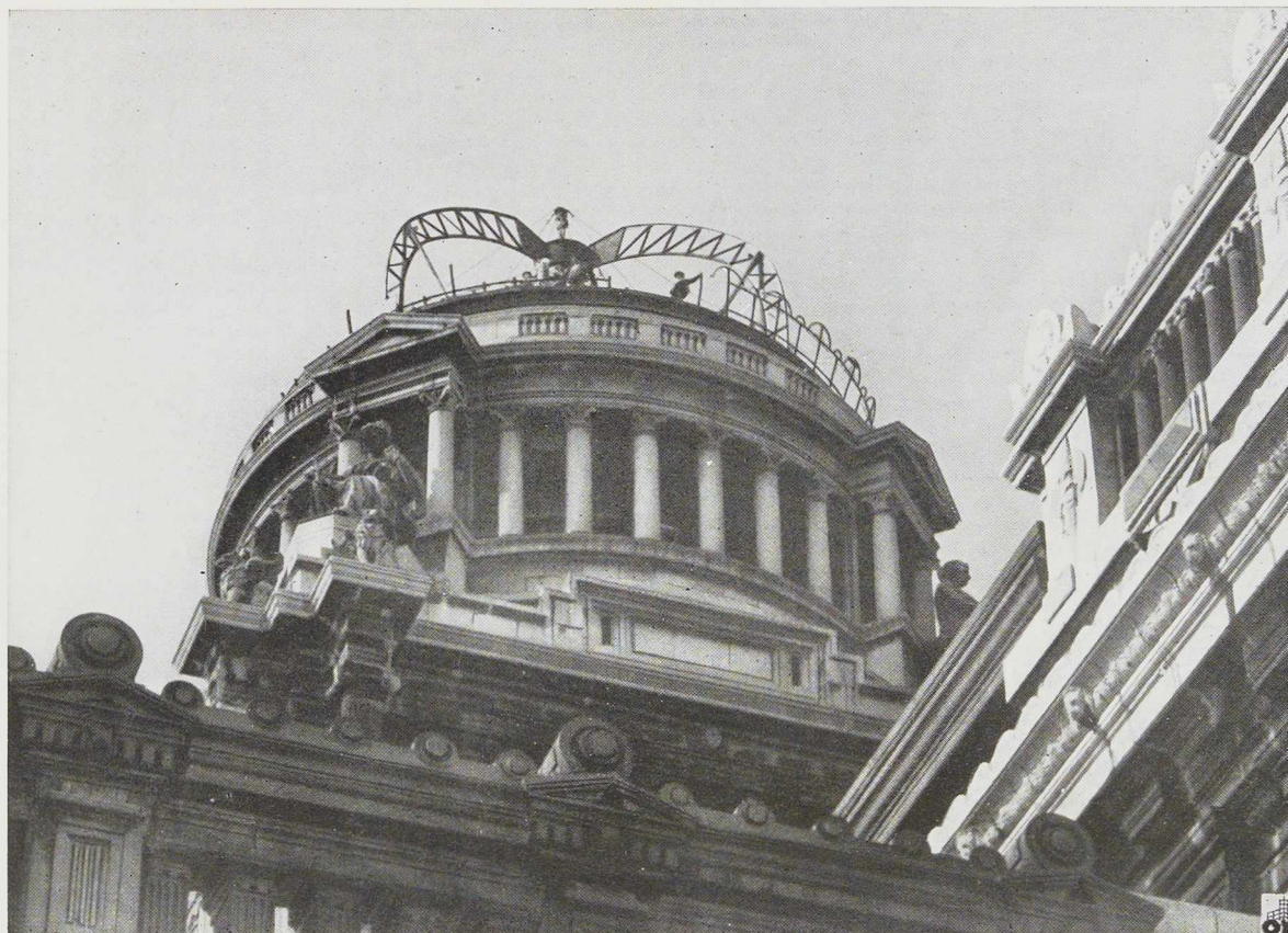
Fig. 367. Ossature métallique du dôme en cours de construction.
