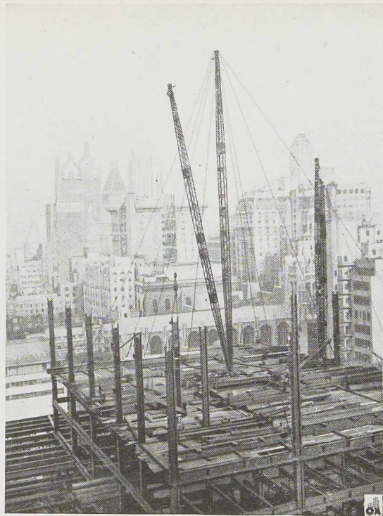
Fig. 404. Vue générale du chantier de l'Esso Building du Rockefeller Center, montrant le derrick en service.
