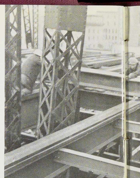
Fig. 407. Au niveau supérieur, provisoire, semblable à celui se bas, et destiné à porter le
