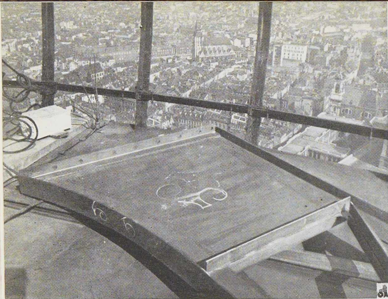
Fig. 368. Pied de la ferme renforcé par une tôle soudée.
