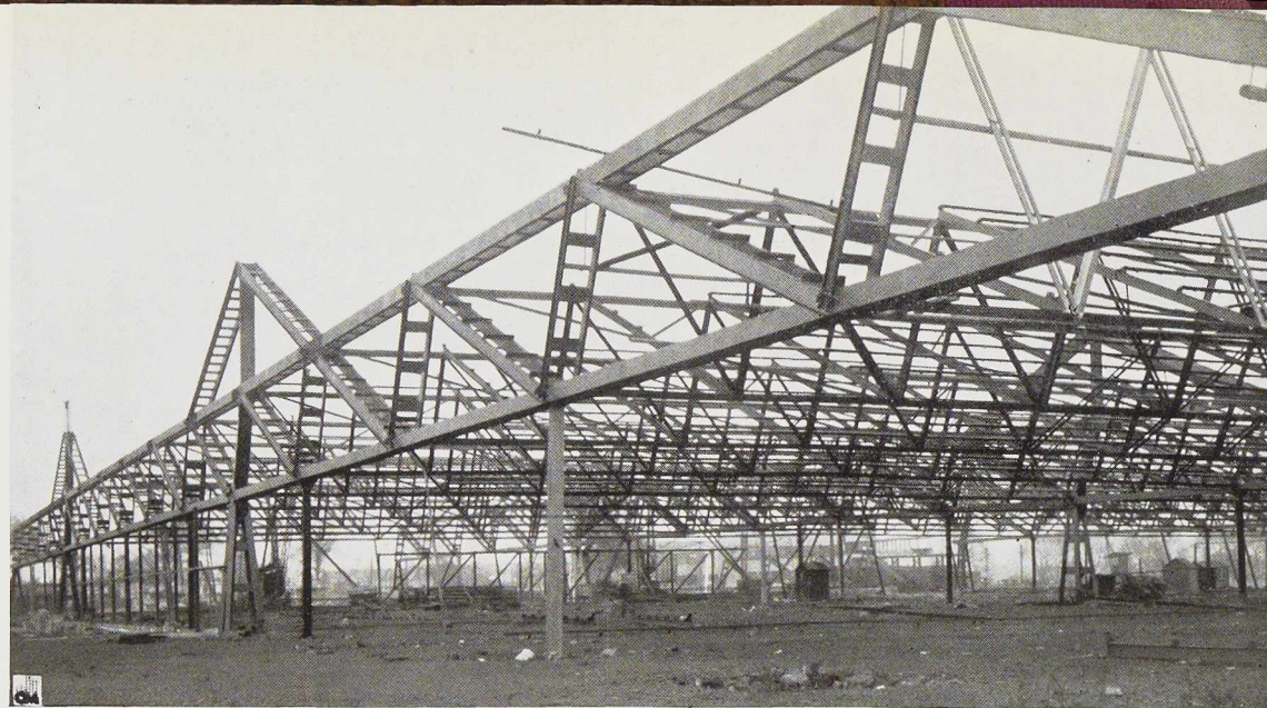
Fig. 356. Hall de la Société Murex Welding Processes Ltd., à Waltham Cross (Angleterre) : exemple de toiture à versants portants réalisée en 1939.
