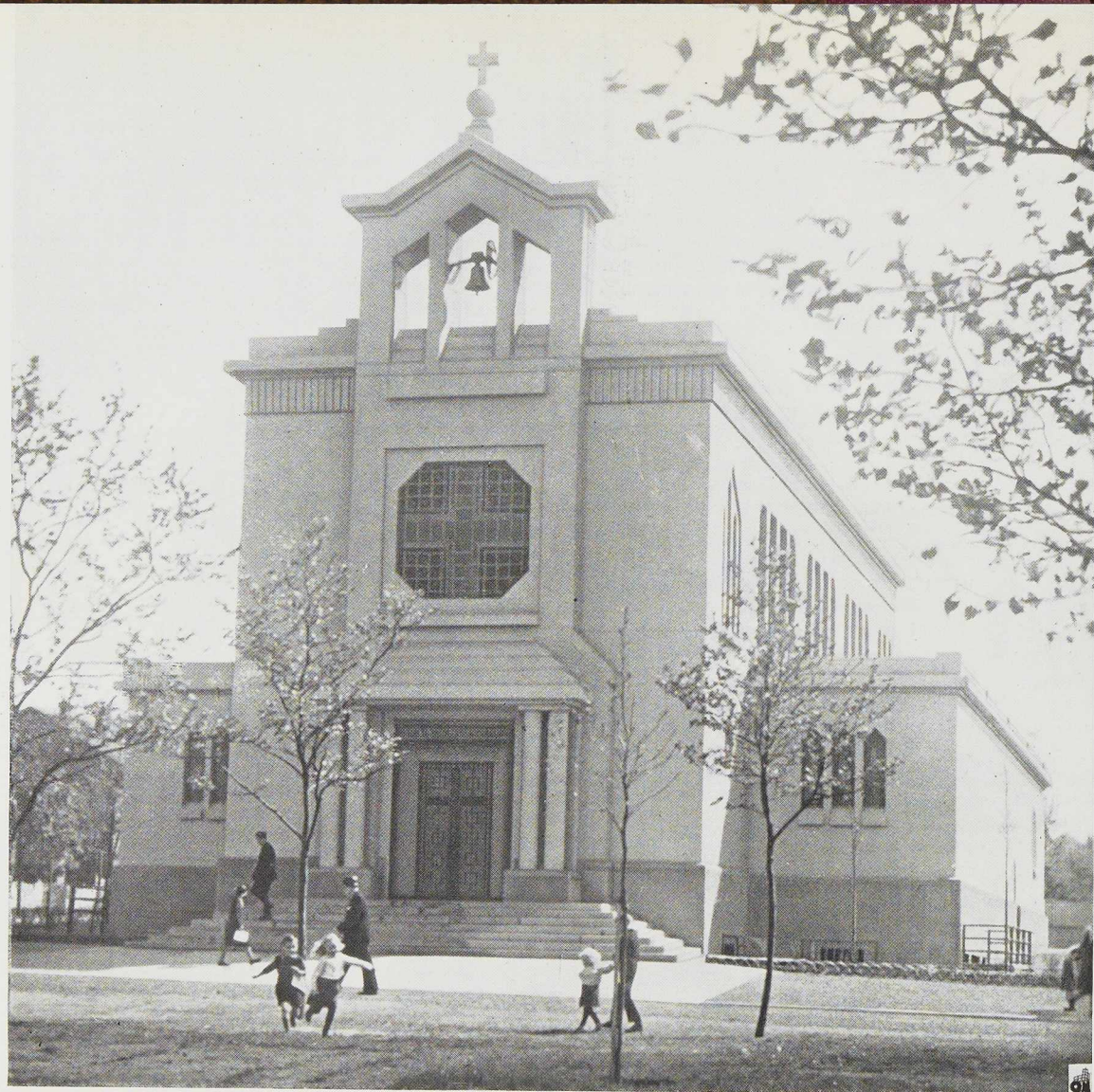
Fig. 262. Eglise de Crusnes, réalisée entièrement en acier, suivant le système Fillod.
