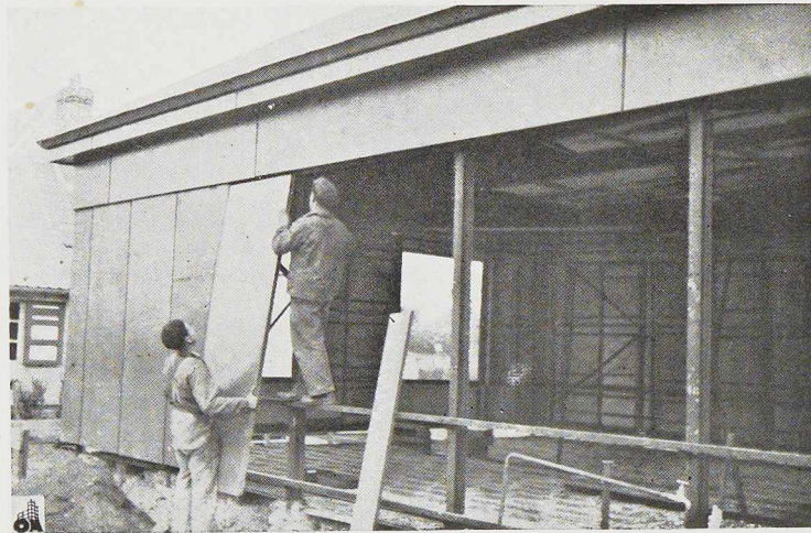
Fig. 276. Pose de revêtements métalliques extérieurs.
