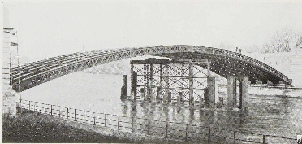
Fig. 236. Vue des arcs à 3 rotules d'une travée de rive du pont de Fragnée, sur la Meuse.
