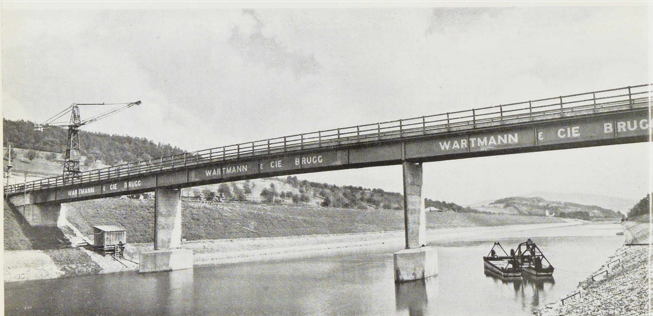
Fig. 186. Vue du pont-route de l'usine hydro-électrique de Rapperswil-Auenstein d'une portée totale de 83 m 60 et comportant un tablier de 3 m 20 de largeur. Le pont a été construit en atelier en grands éléments de 33 m 58, 19 m 00 et 31 m 58 de portée. Une palée provisoire en rivière a été établie pendant les travaux.
