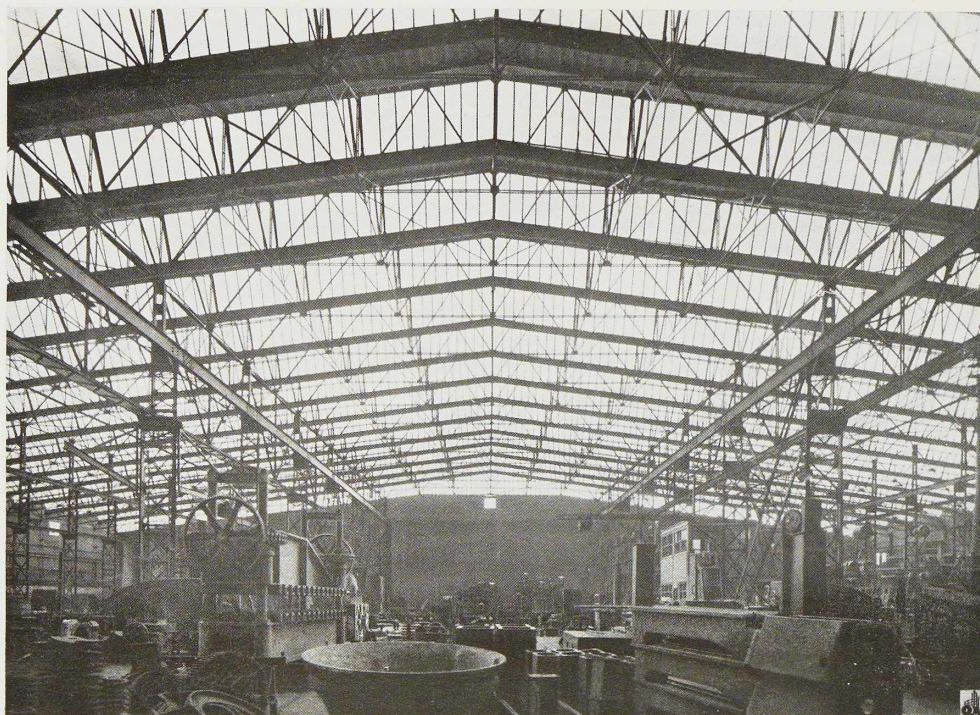
Fig. 164. Vue intérieure de la tournerie dont le hall central est destiné au parachèvement des pièces de grandes dimensions.
