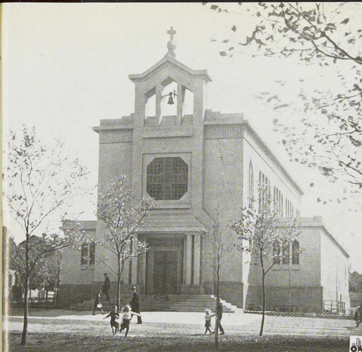
Fig. 85. Eglise entièrement métallique de Crusnes, érigée en 1936, montrant une illustration intéressante des possibilités qu'offre l'acier au point de vue architectural.
