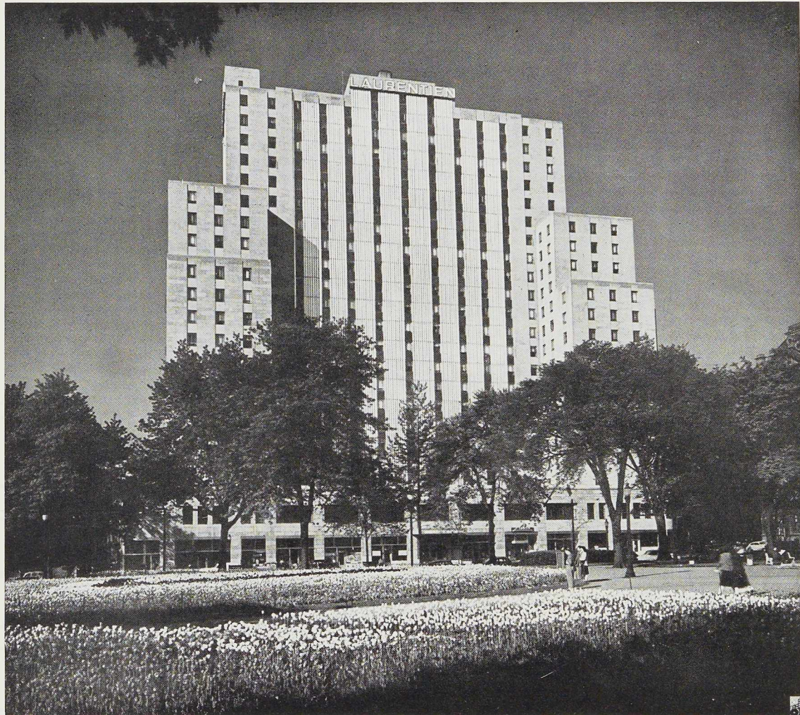
Photo Richard Arless Assoc. Fig. 781. Vue générale du Laurentien Hotel à Montréal.
