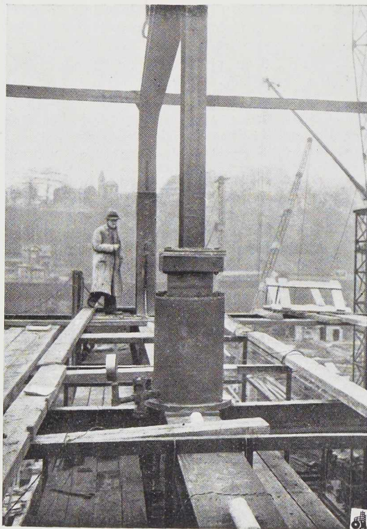
Fig. 758. Vérin hydraulique utilisé pour l'application des efforts verticaux opposés aux milieux des deux poutres d'une ferme.
