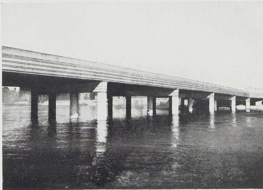
Fig. 802. Vue générale du pont de Saint-Cloud.
