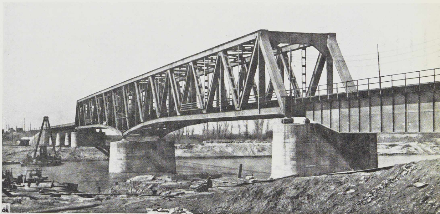
Fig. 616. Le pont reconstruit sur la Tisza, à Szolnok.
