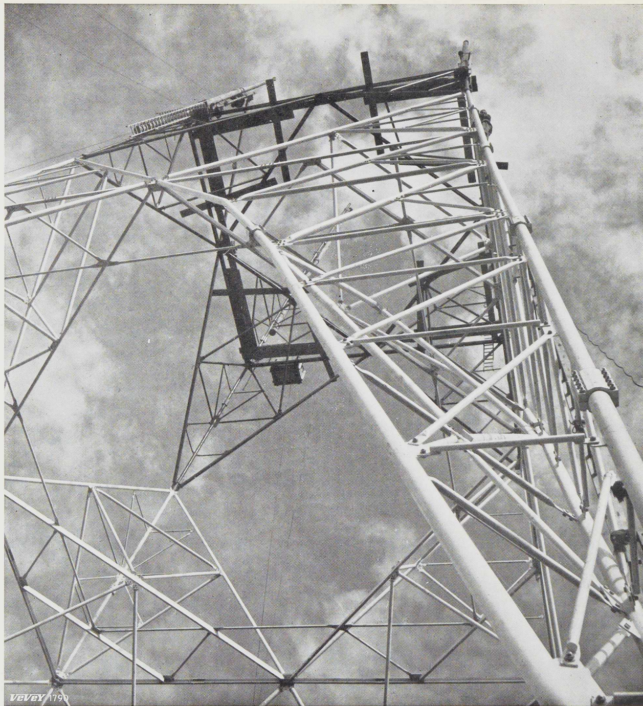
Fig. 655. Montage de la partie inférieure du pylône d'antenne à Sottens.
