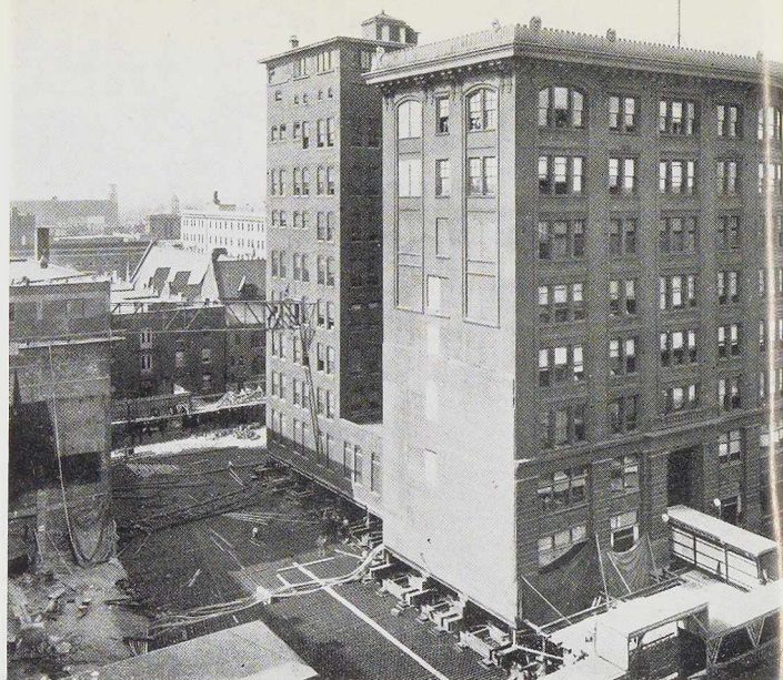
Fig. 670. Vue du bâtiment à son emplacement initial. On note le grillage en poutrelles métalliques sur lequel le bâtiment va d'abord être ripé.
