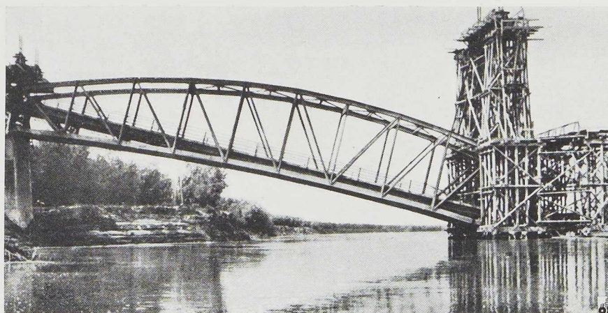
Fig. 621. Relevage de la travée tombée du pont de Csongràd.
