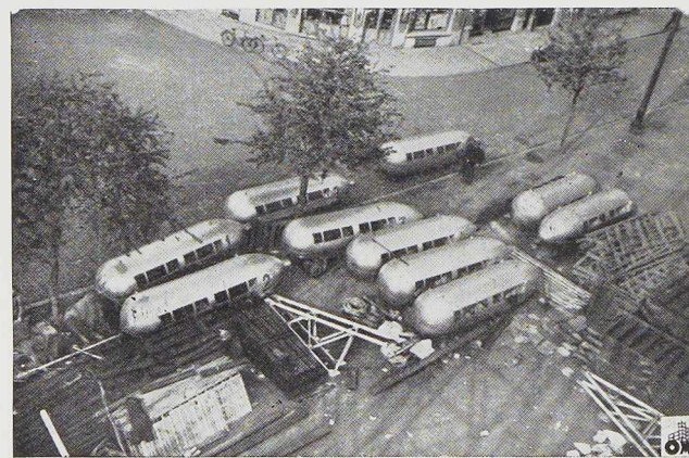
Fig. 644. Nacelles, en tôle d'acier, en forme de fusée.
