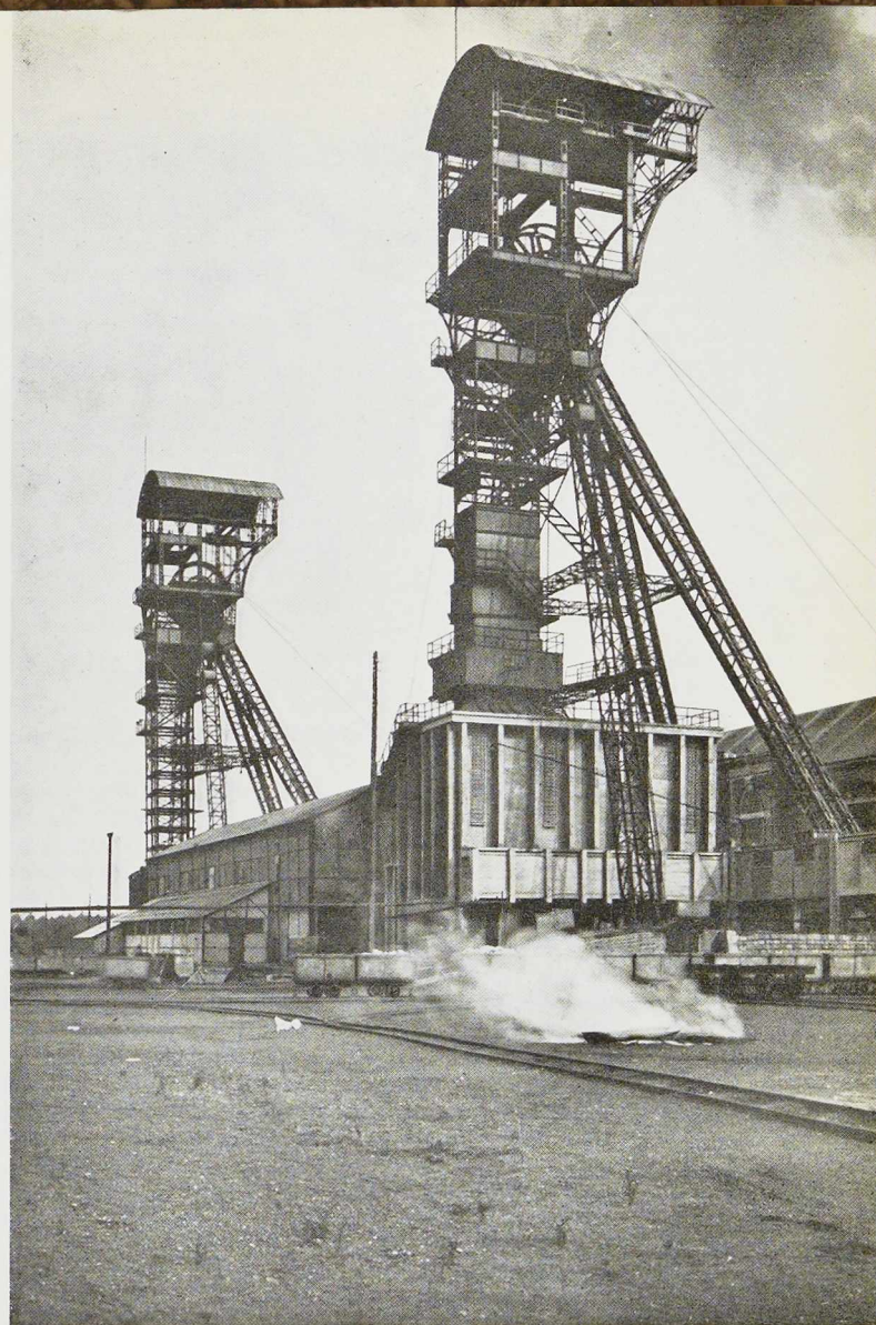
Fig. 430. Chevalements du Siège de Voort des Charbonnages de Helchteren et Zolder. Situation ancienne, deux machines d'extraction à vapeur, cage à 8 chariots, quatre molettes de 6 mètres de diamètre à jante en fonte. Actuellement, après consolidation des chevalements, le service est assuré par : trois machines d'extraction électriques, cages à 10 chariots, six molettes de 6 mètres de diamètre à jante en acier laminé.
