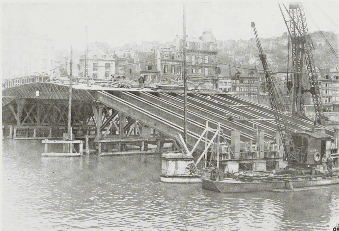
Fig. 459. Vue du cintre en poutrelles H du pont des Arches à Liège.
