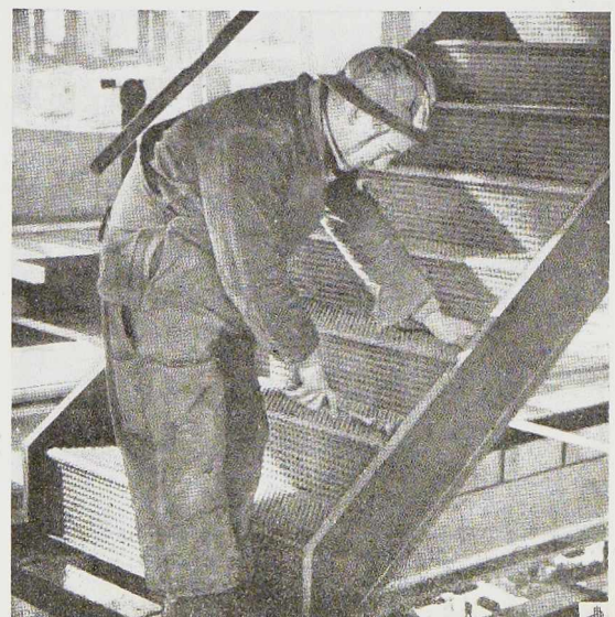
Fig. 486. Montage d'un des escaliers métalliques dans un nouveau bâtiment en construction à New-York.
