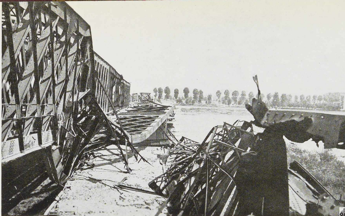
Fig. 454. Vue du pont de Crémone sur le Pô détruit au cours de la guerre.
