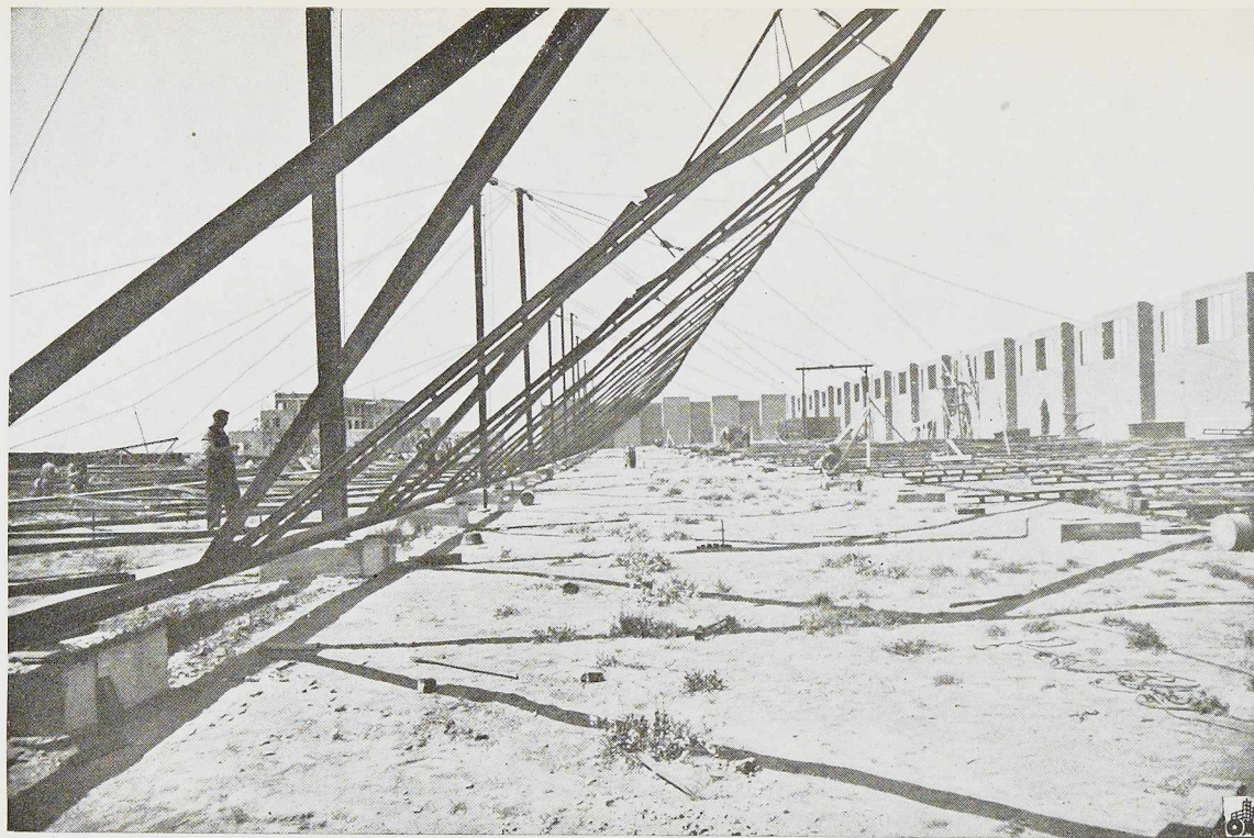
Fig. 372. Vue de la demi-poutre en treillis prise pendant son retournement.
