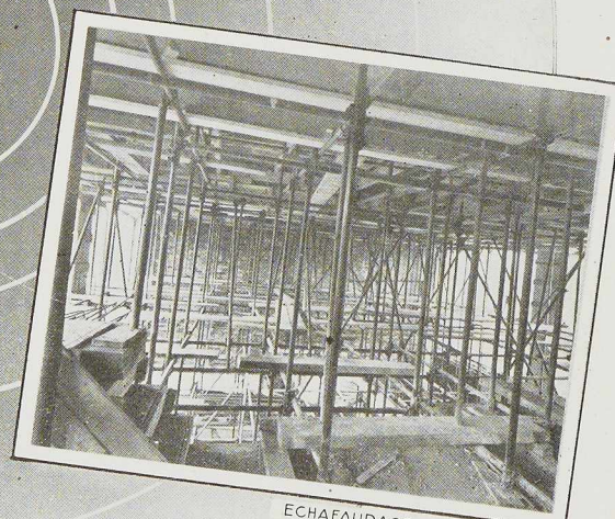
ECHAFAUDAGE SERVANT D'ETANÇON
