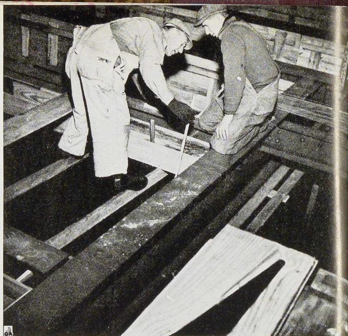
Fig. 299. Construction des coffrages pour le plancher en béton de cendrée réalisés sans étançon.
