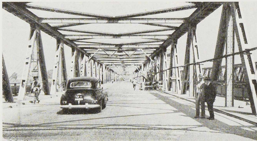
Fig. 344. Pont-route sur le Waal à Zaltbommel. Il comporte trois travées de 126 m 96 et quatre travées de 120 m 60. A droite se profile le pont-rails dont une vue est donnée à la figure 345.
