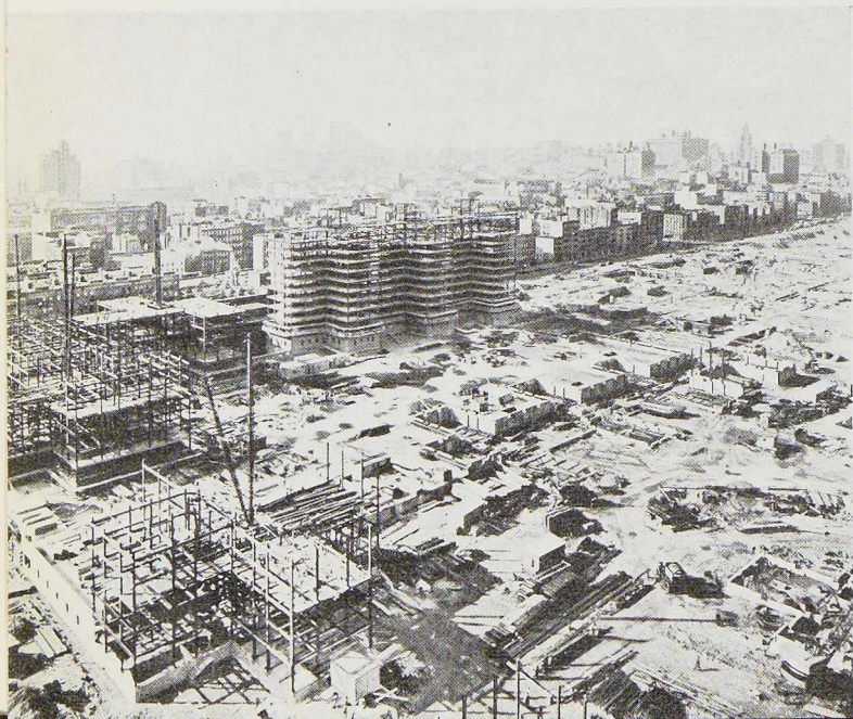
Fig. 290. Vue partielle du chantier de Stuyvesant Town montrant les ossatures métalliques des immeubles en cours de montage.
