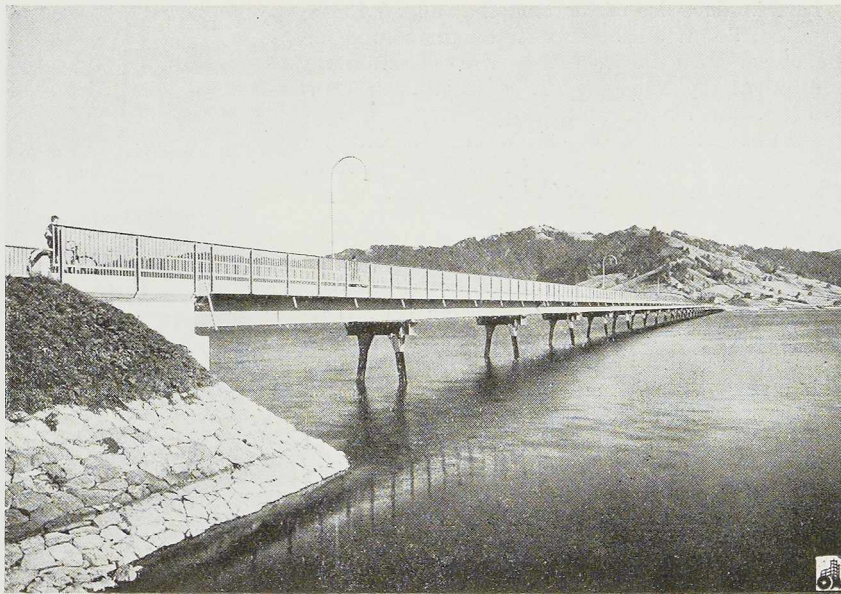
Fig. 308. Pont de Willerzell d'une longueur de 1.115 mètres.
