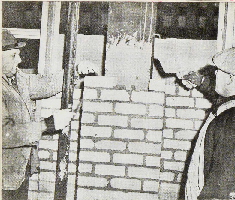
Fig. 298. Accrochage des pierres de façade à l'ossature métallique; la maçonnerie adossée à la pierre enrobe l'ossature.
