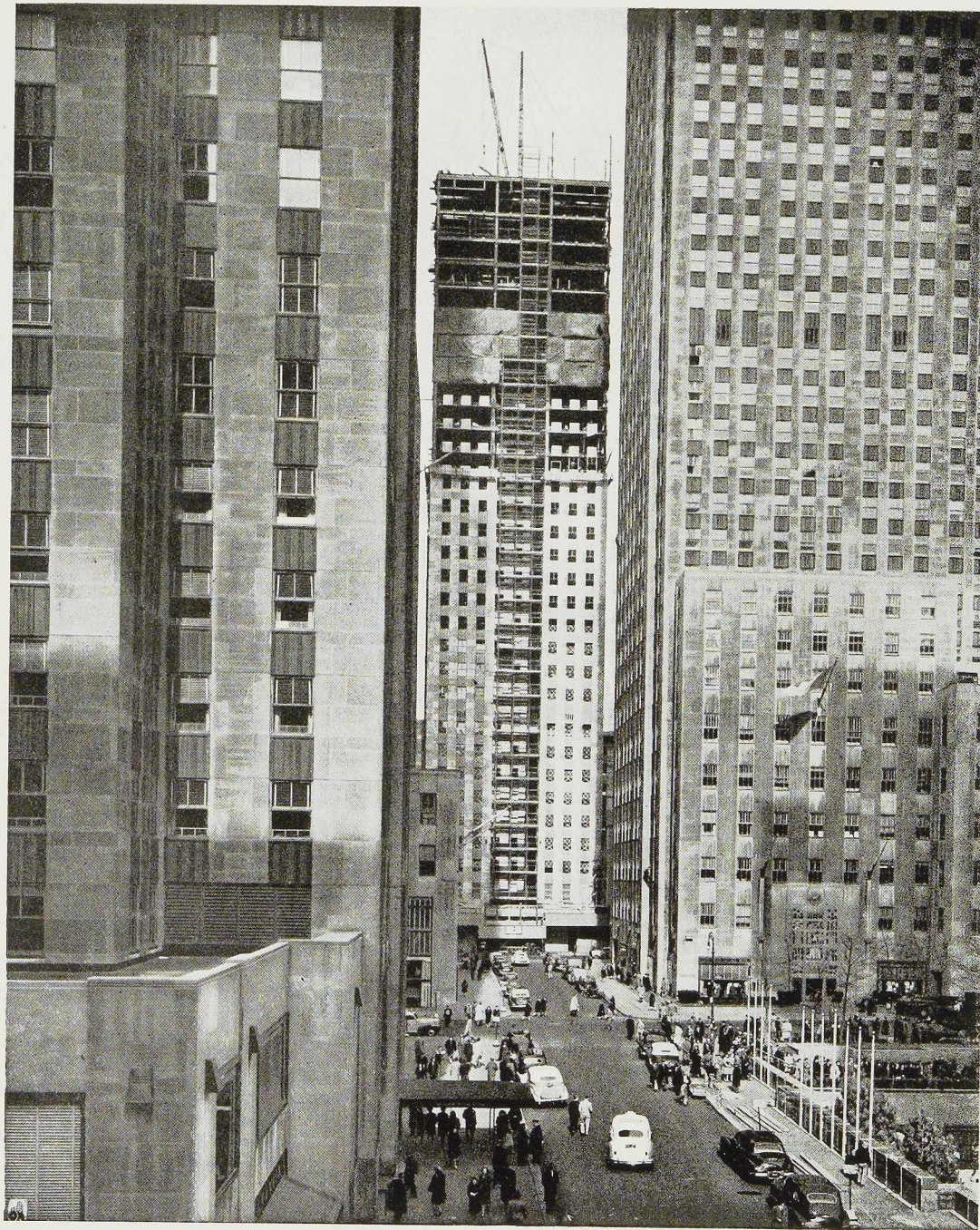
Fig. 297. Tour centrale à l'Esso Building dont l'ossature métallique est virtuellement achevée (vue prise le 4-3-47).
