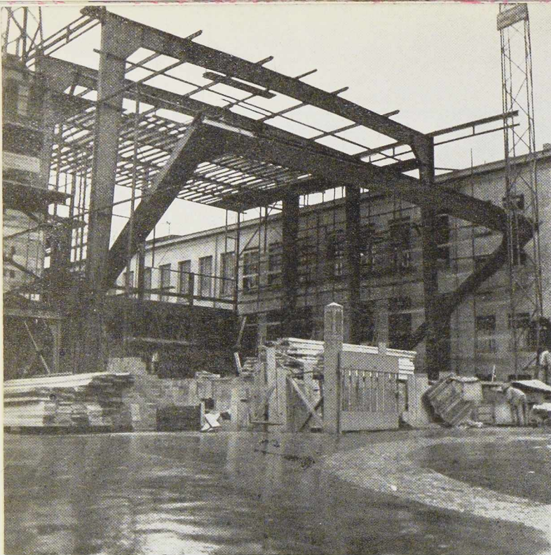
Fig. 217. Montage d'un hall de la Société B. B. C. (Suisse). (Cliché V. S. B.)
