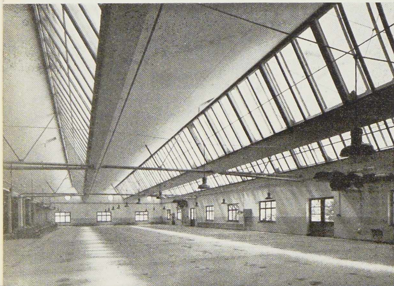
Fig. 218. Vue d'une charpente en shed des Ateliers Stehli à Obfelden. (Cliché V. S. B.)
