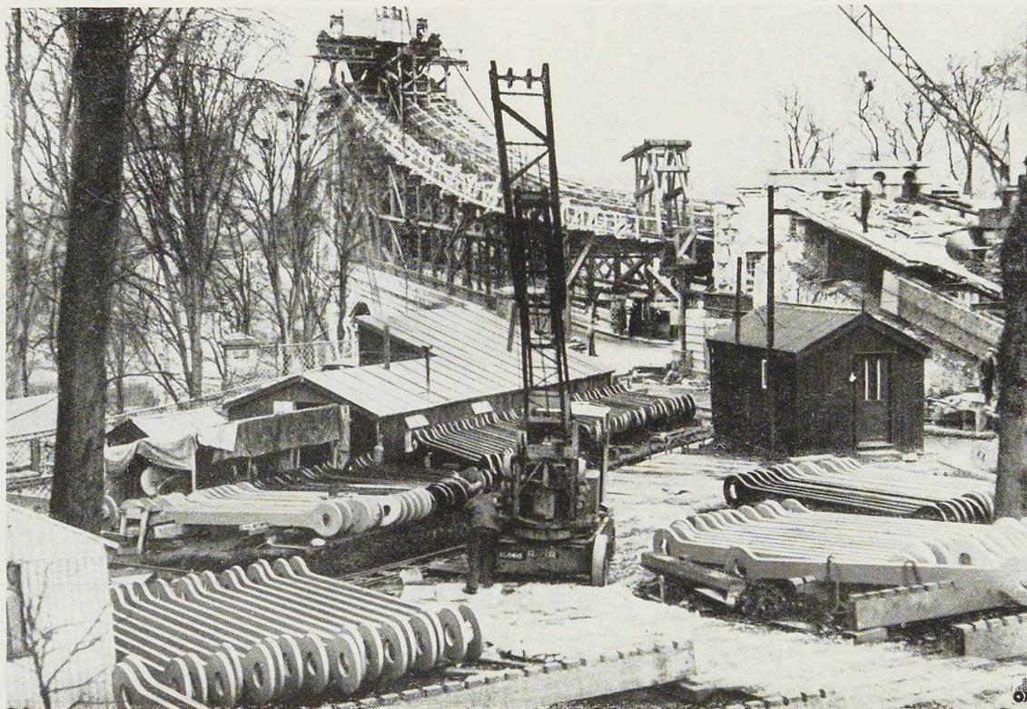
Fig. 185. Éléments en acier destinés au pont suspendu de Menai (Grande Bretagne) métallisés au zinc par le procédé Schori.
