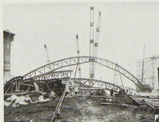
Fig. 137. Montage des cintres en acier du viaduc de Renory.
