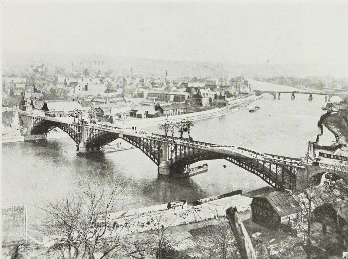
Fig. 138. Cintres métalliques du pont de Huy avec ponts roulants sur portiques.
