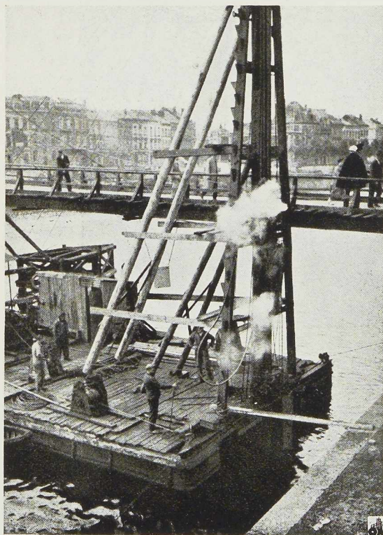
Fig. 96. Battage des poutrelles de fondation.
