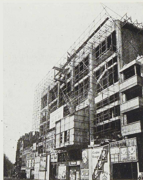
Fig. 78. Echafaudage en tubes d'acier utilisé pour la construction du Lycée Léonie de Waha, à Liège.
