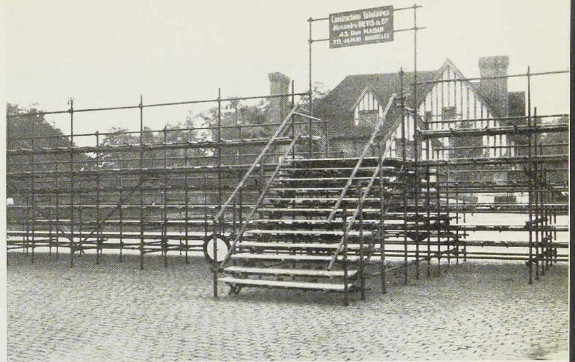
Fig. 81. Tribune de 320 places assises, en construction tubulaire édifée à Bruxelles pour le Grand Prix Automobile de Belgique (juin 1946). La tribune a une longueur de 34 mètres.
