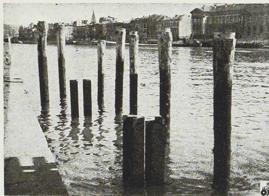
Fig. 97. Poutrelles inférieures des palées d'appui.
