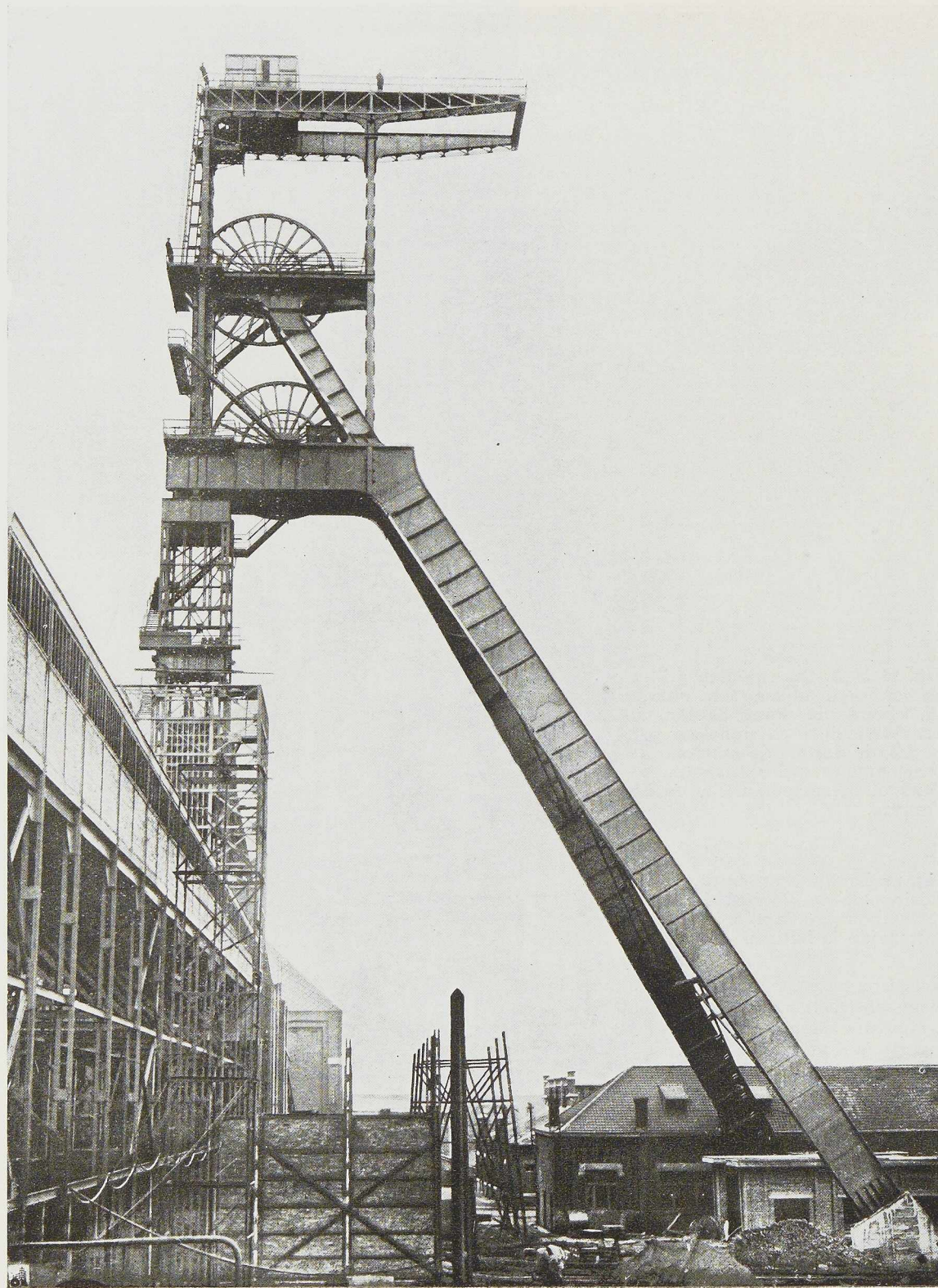
Fig. 21. Vue d'ensemble du nouveau chevalement au puits Marie-José des charbonnages de Maurage avec ses deux molettes en place.
