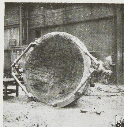
Fig. 632 à 634. Préparation du moule, coulée et nettoyage d'une demi-sphère.
