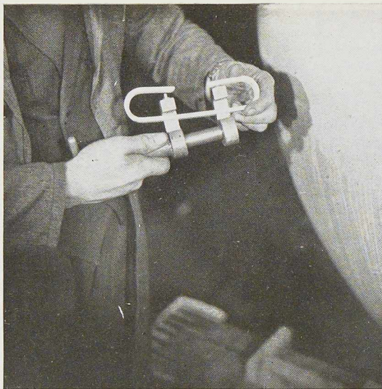
Fig. 642 et 643. Outil servant au placement des 400 petits ressorts appliquant les deux demi-sphères l'une contre l'autre avec un effort total de 30 tonnes; la figure 643 montre les deux hémisphères comportant déjà plusieurs de ces ressorts.
