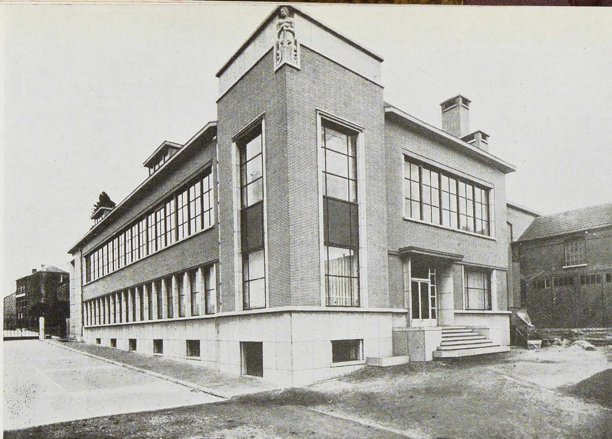
Bureaux des Ateliers du Thiriau, La Croÿère.
