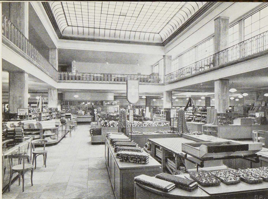
Fig. 580. Vue intérieure des magasins Jelmoli à Zurich. On note l'absence de toute poutraison apparente dans les plafonds.
