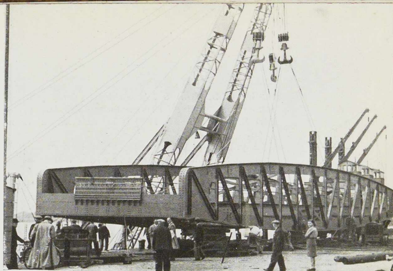
Fig. 573. Après son montage à 2 kilomètres en aval de son emplacement définitif, une bigue flottante de 150 tonnes soulève le pont pour le transport.
