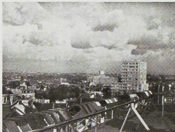
Fig. 616. Vue de la station de Bruxelles, sur le toit de la Sofina, montrant la disposition des chevalets et des éprouvettes.
