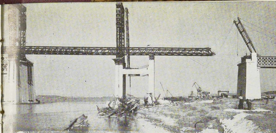
Fig. 541. Lancement simultané des 2 travées provisoires fixes et de la travée levante.
