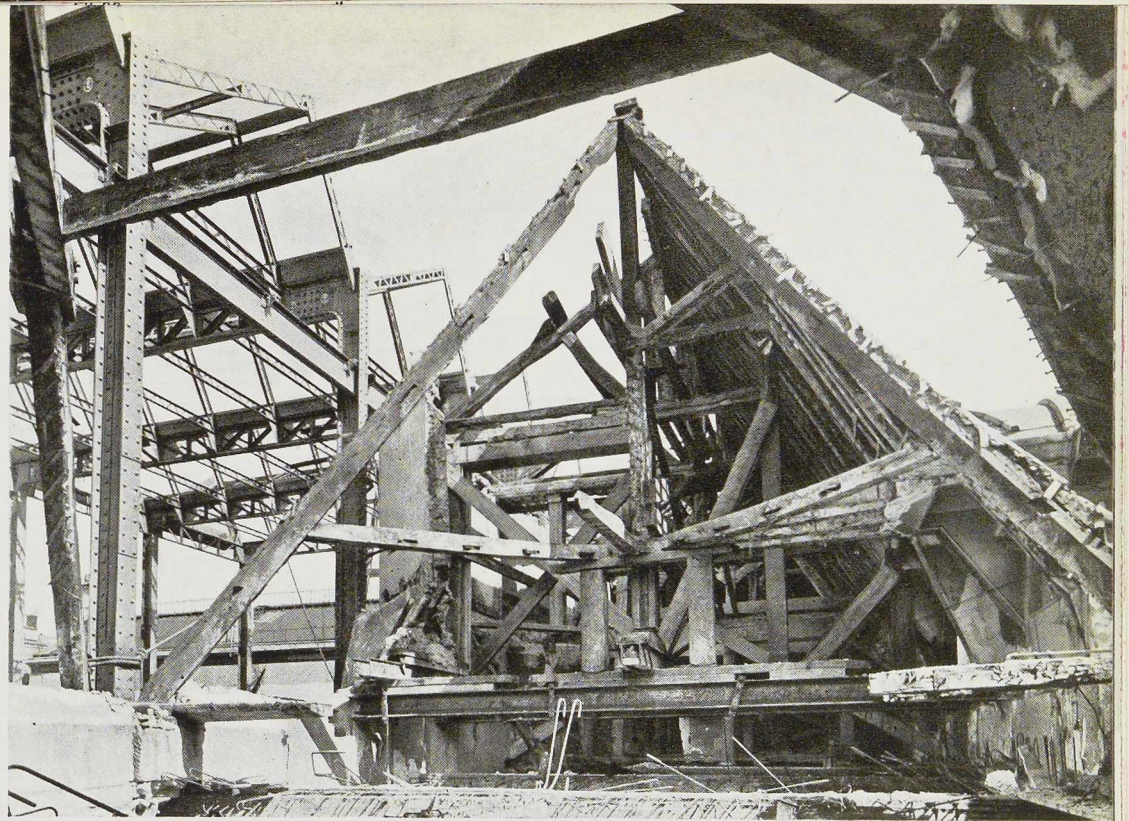
Fig. 495. Charpente métallique en cours de montage; au premier plan, l'ancienne charpente remplacée ultérieurement, en conservant les lucarnes.
