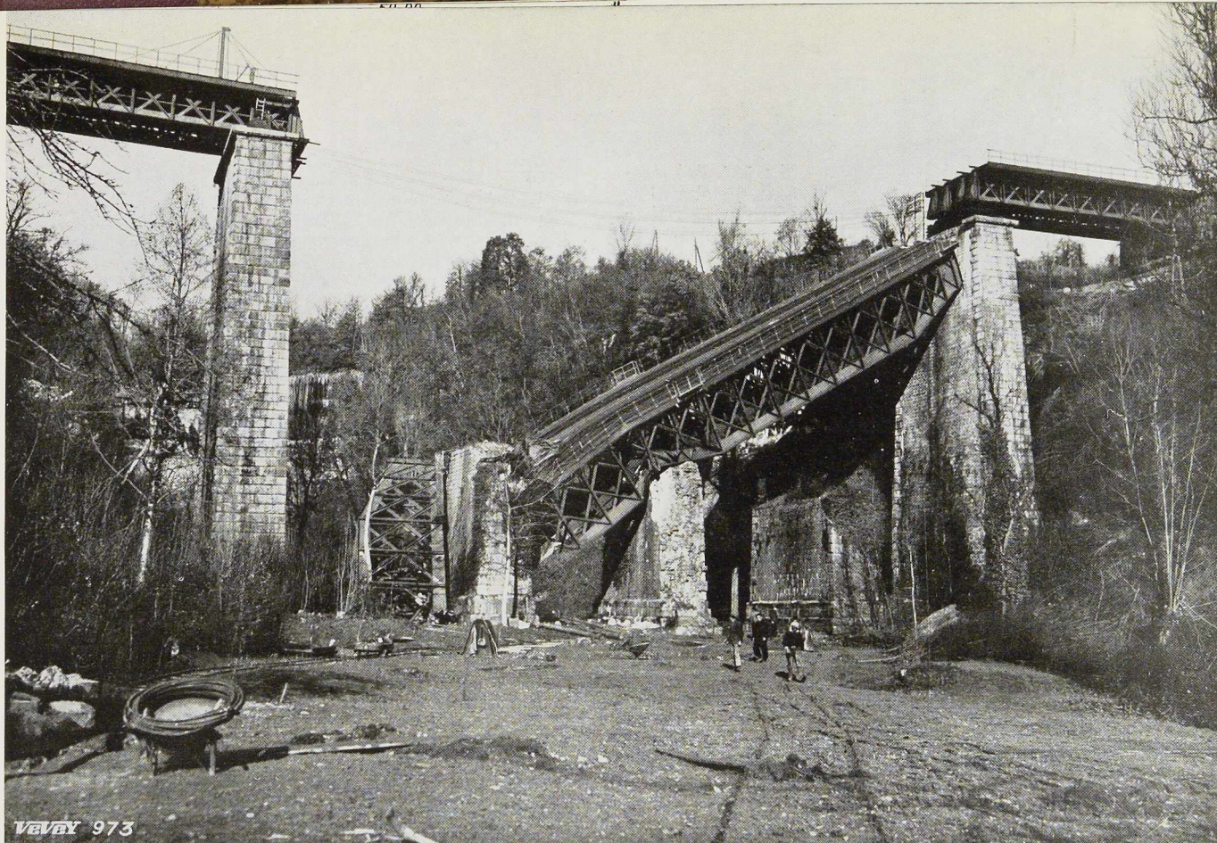
Fig. 501. Le pont de Pyrimont (France) avant son relevage.
