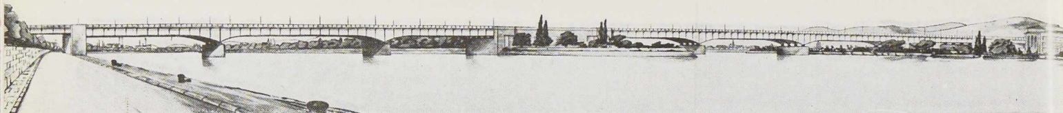
Fig. 511. Pont Arpád à Budapest. Vue prise d'amont.
