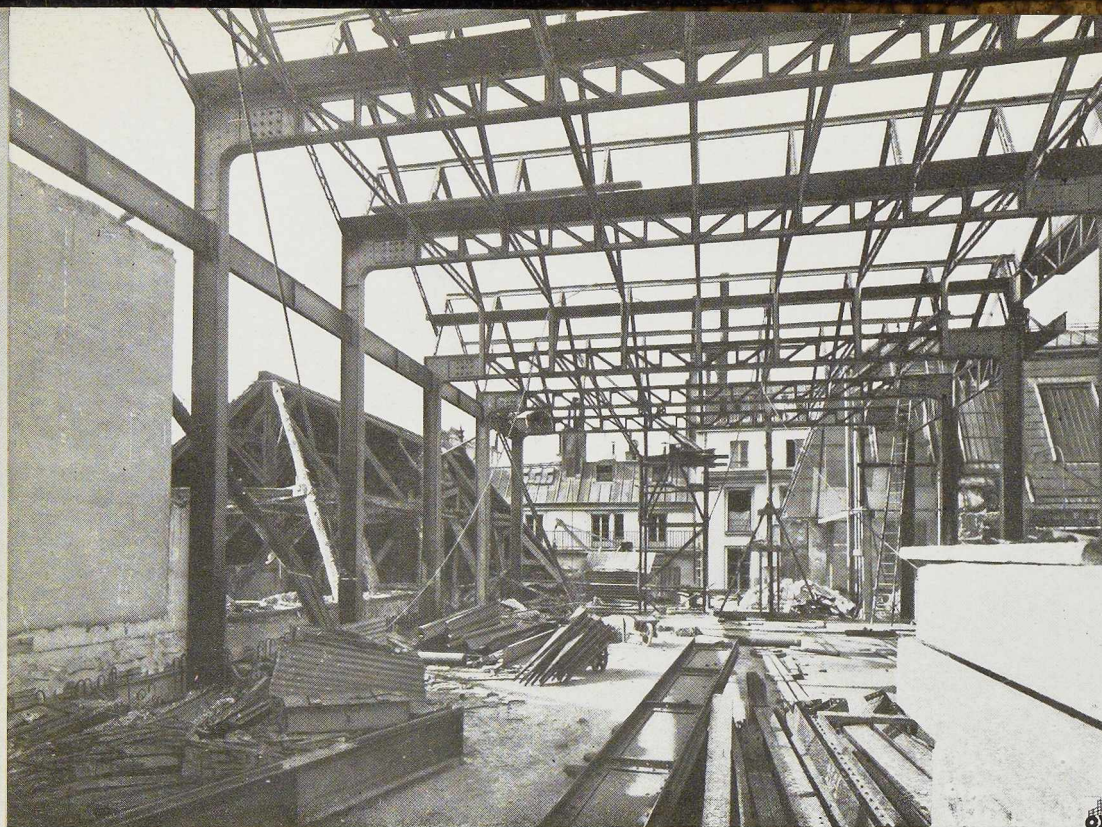
Fig. 494. Charpente métallique en sheds de la grande salle de lecture en cours de montage.
