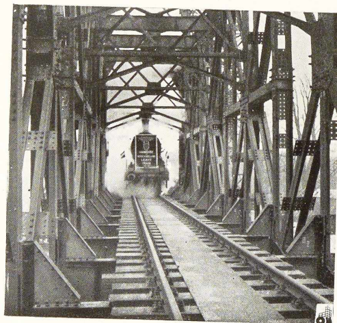
Fig. 293. Pont-rails sur l'Yssel à Daventer (Pays-Bas). Cet ouvrage détruit pendant la guerre a été reconstruit par le génie britannique.
