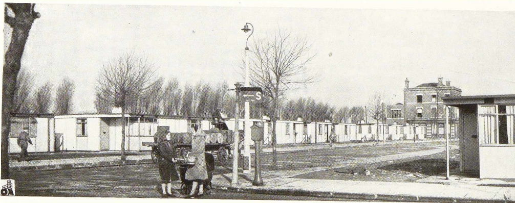
Fig. 294. Une cité de maisons métalliques préfabriquées en Angleterre.
