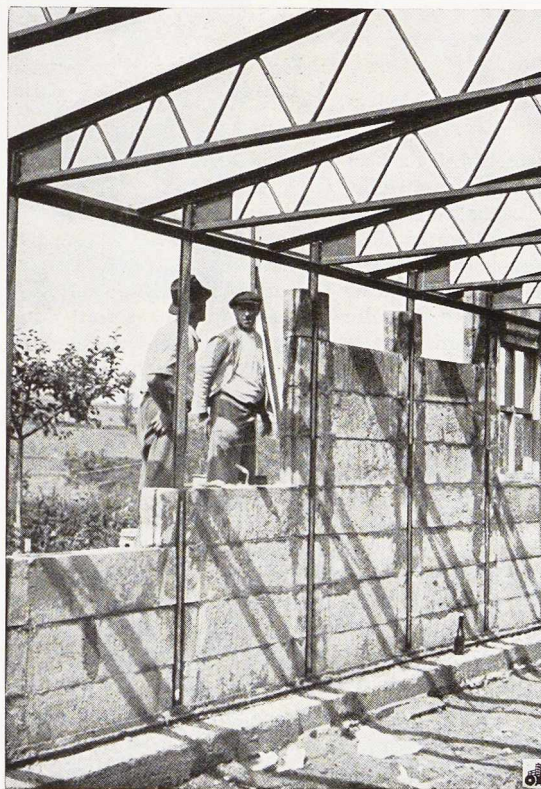
Fig. 155. Pose de blocs de béton formant parois extérieures.
