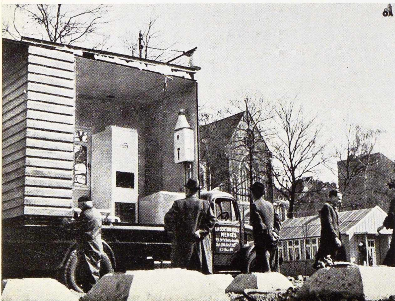
Fig. 146. Mise en place du débarras-cave complètement équipé.
