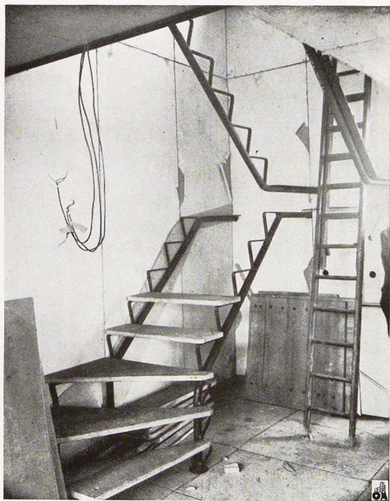
Fig. 173. Escalier à charpente tubulaire en acier, les marches étant en chêne.
