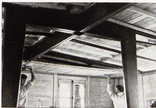
Fig. 163. Pose des panneaux formant le plafond, dissimulant la poutraison.
