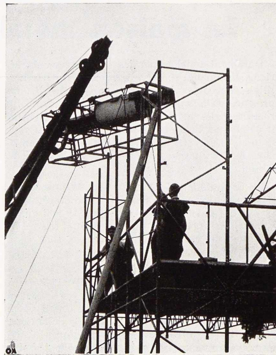
Fig. 172. Montage du bloc chauffage.
