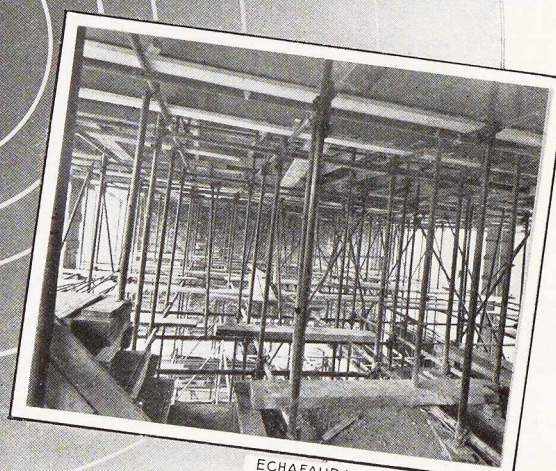
ECHAFAUDAGE SERVANT D'ETANÇON
