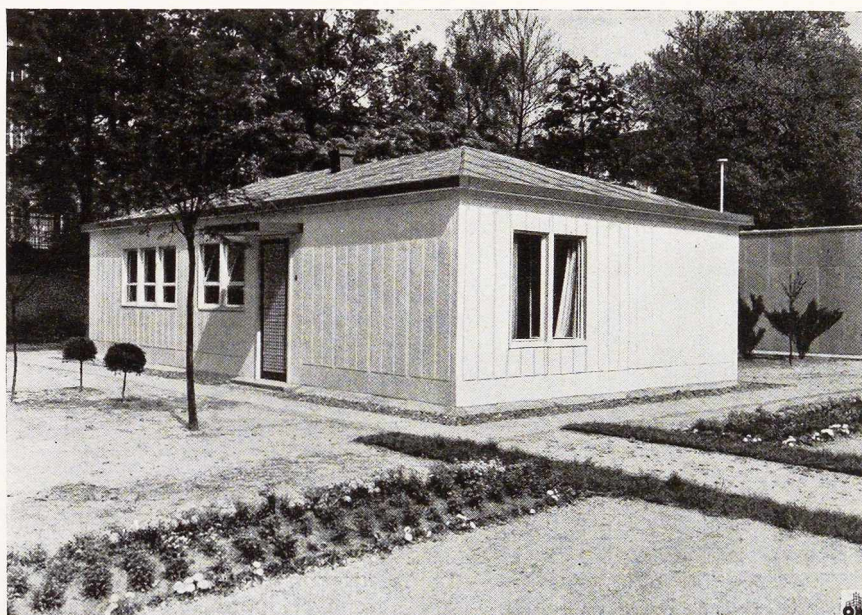
Fig. 135. Maison métallique « Acia ».
