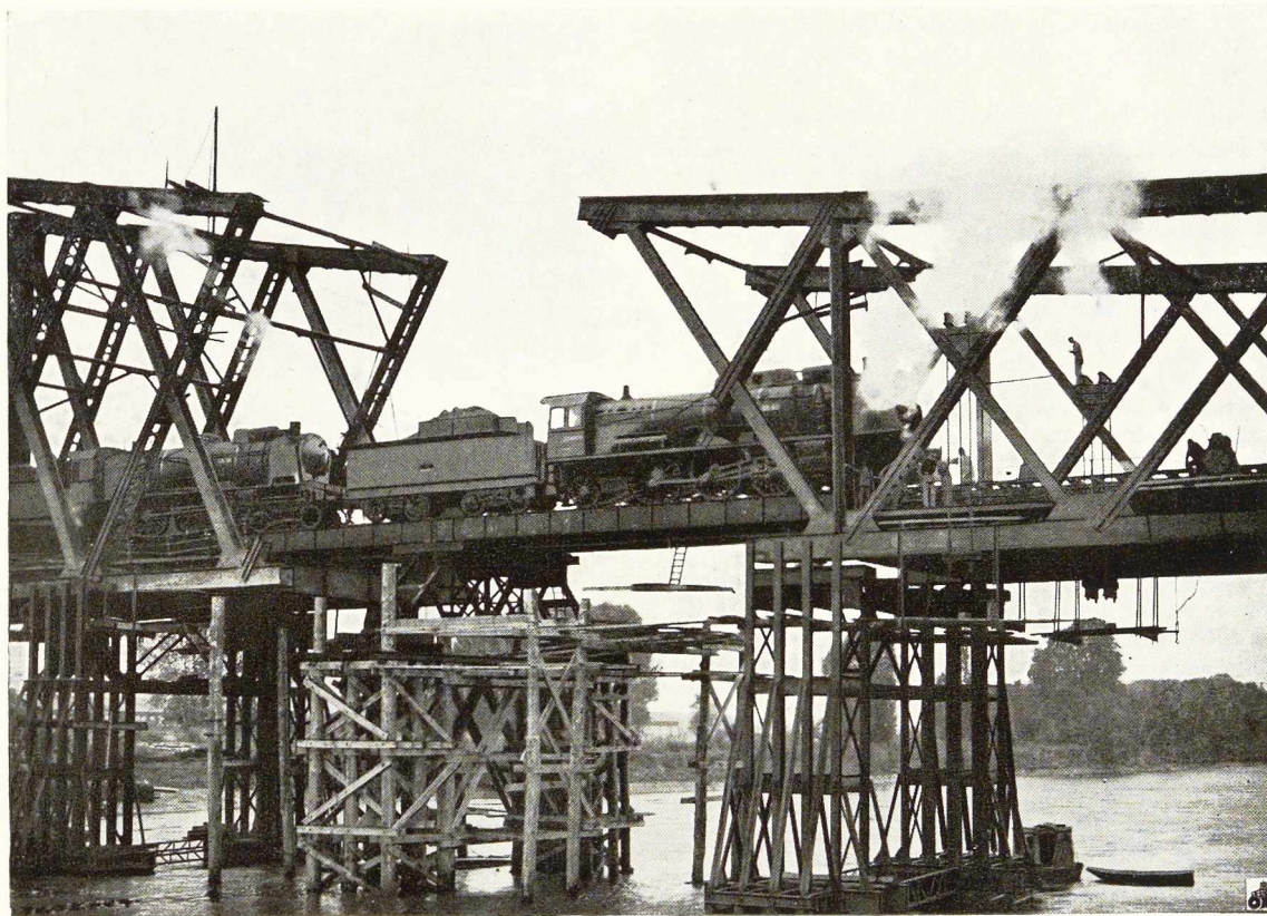
Fig. 351. Viaduc d'Eauplet sur la Seine. Vue prise pendant les essais de charge.
