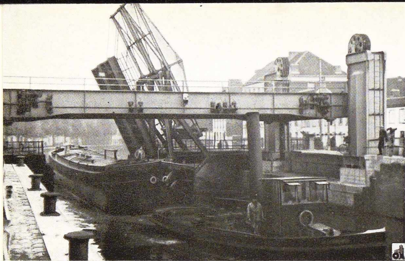
Fig. 312. Vue du pont en position ouverte.
