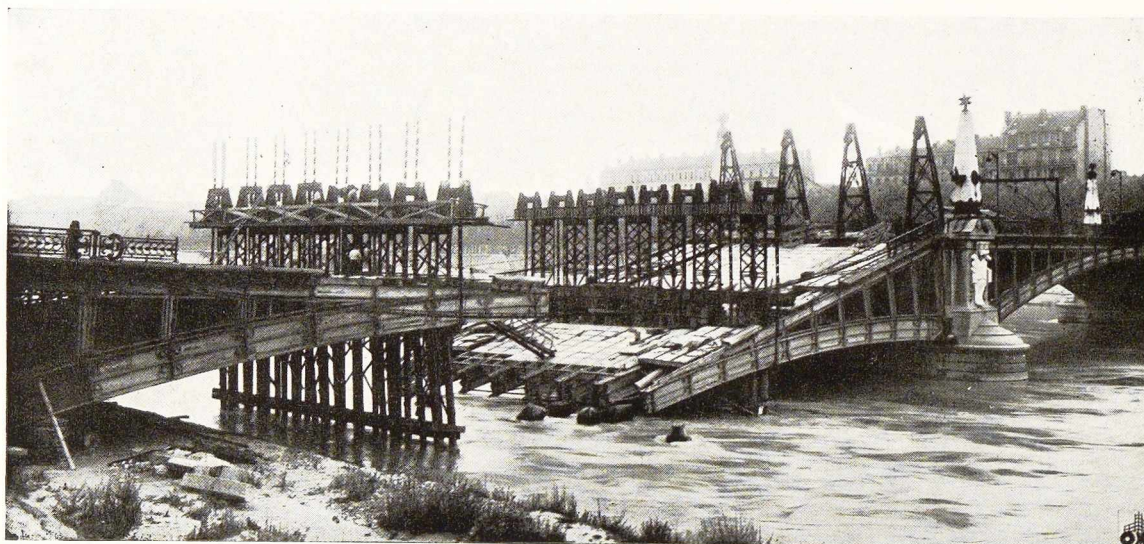
Fig. 340. Relevage d'une demi-arche du pont Galliéni après coupure de la clé hors de l'eau (juillet 1945).
