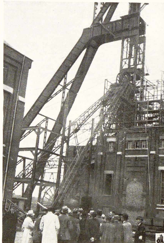
Fig. 362. Les membres de l'A. I. P. C. examinant le chevalement de mines au charbonnage de Maurage.
