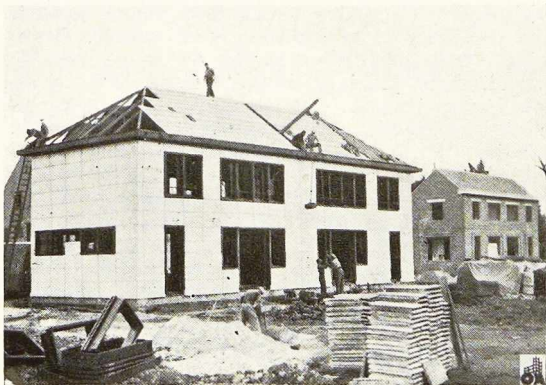
Fig. 364. Maison préfabriquée système Schwartz-Hautmont à l'Exposition de Roubaix-Tourcoing.
