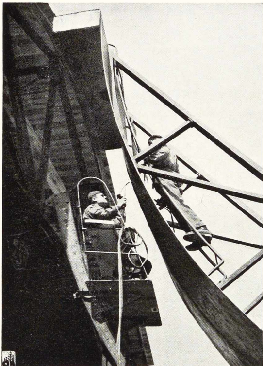
Fig. 336. Soudage oxy-acétylénique, en montage, des éléments de coupole inférieure.
