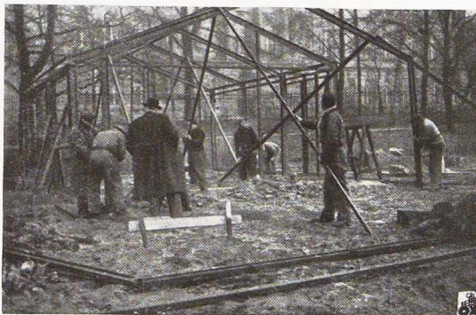
Fig. 31. Maison Copreco (en montage).
