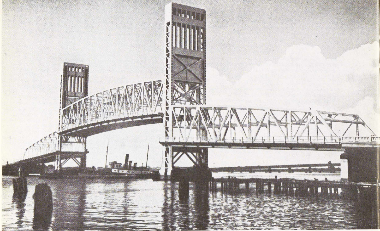
Fig. 33. Pont mobile franchissant le St. John's River à Jacksonville (Floride) : La travée mobile a une portée de 117 m 75, les deux travées fixes une portée de 259 m 50. Mention honorable, classe des ponts mobiles.
