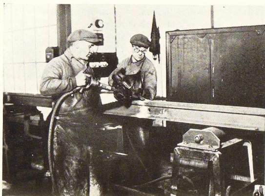
Fig. 305. Profilage du rail à l'endroit de la soudure.
