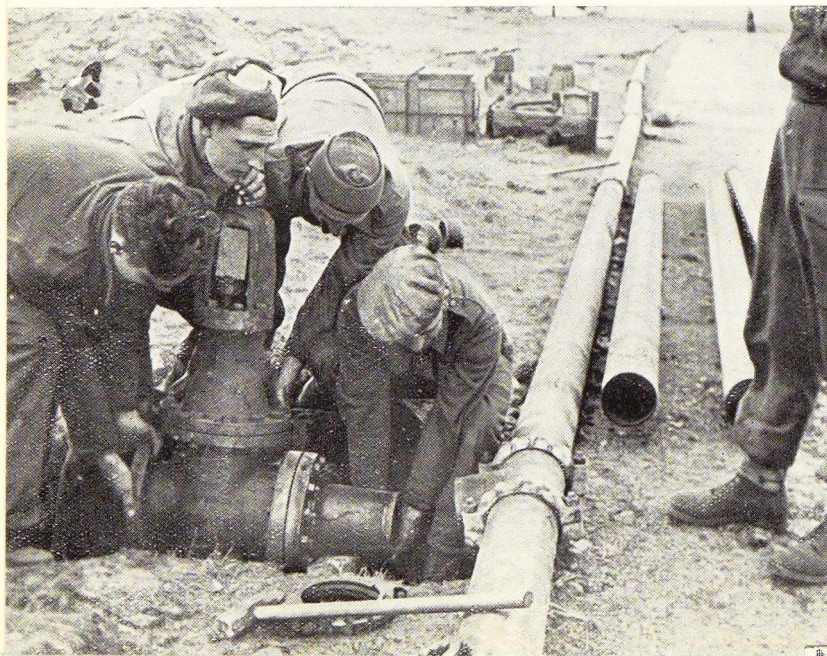
Fig. 242. Pose d'une vanne du pipe-line terrestre à Boulogne, en octobre 1944.
