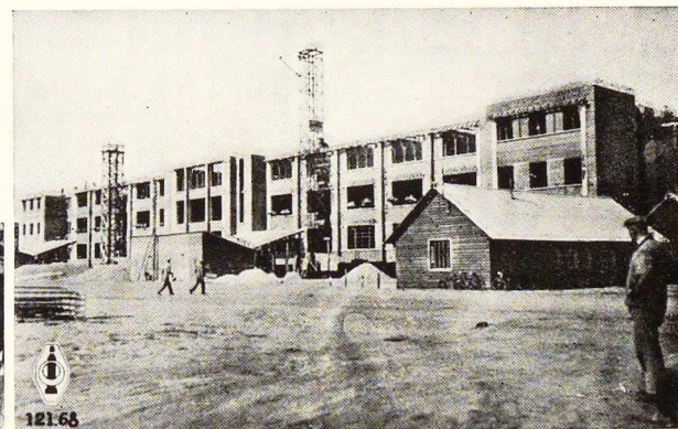
Fig. 253. Installation des casernes de Turnhout, système « Crittall ».
