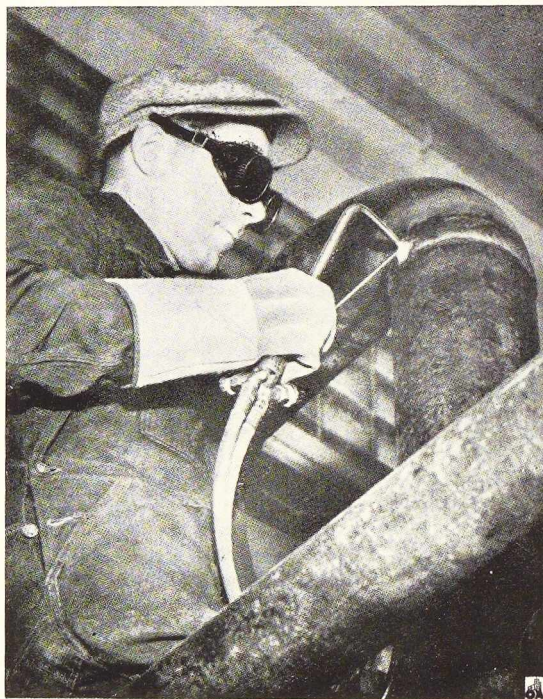
Fig. 255. Soudure d'une tuyauterie de vapeur.
