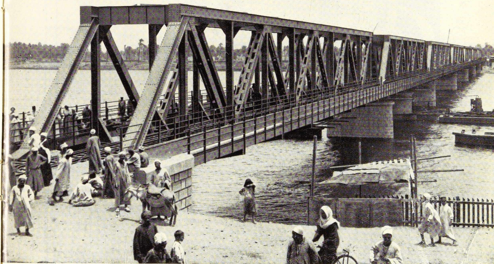
PONT SUR LE NIL A NAG HAMADI. Longueur : 453 m Largeur : 12,1 m. Poids : 2.100 t.
