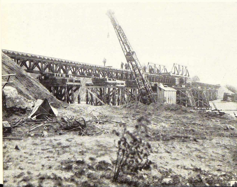
Fig. 183. Pont provisoire de Herenthals du type militaire.
