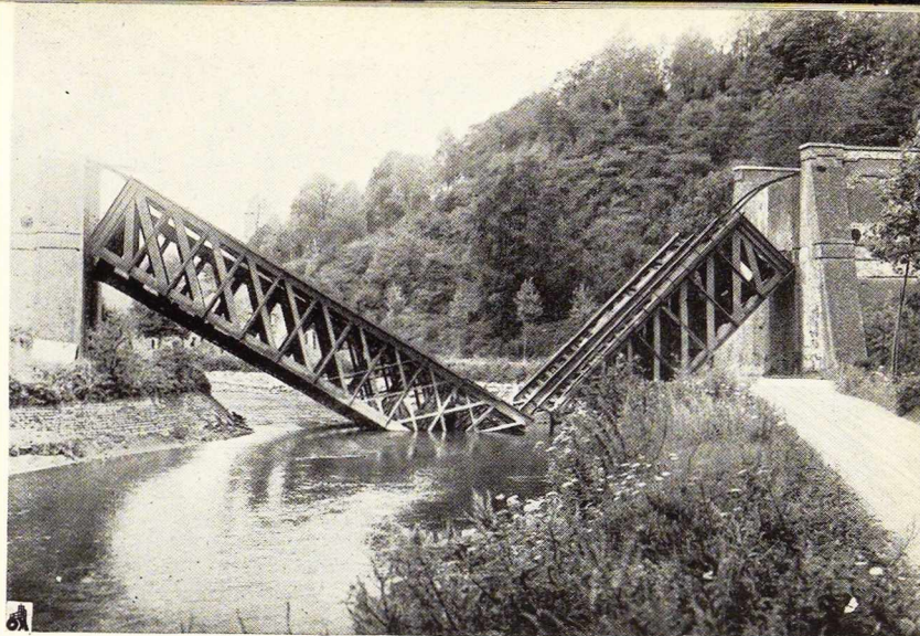
Fig. 180. Pont à Lobbes, au-dessus de la Sambre.
