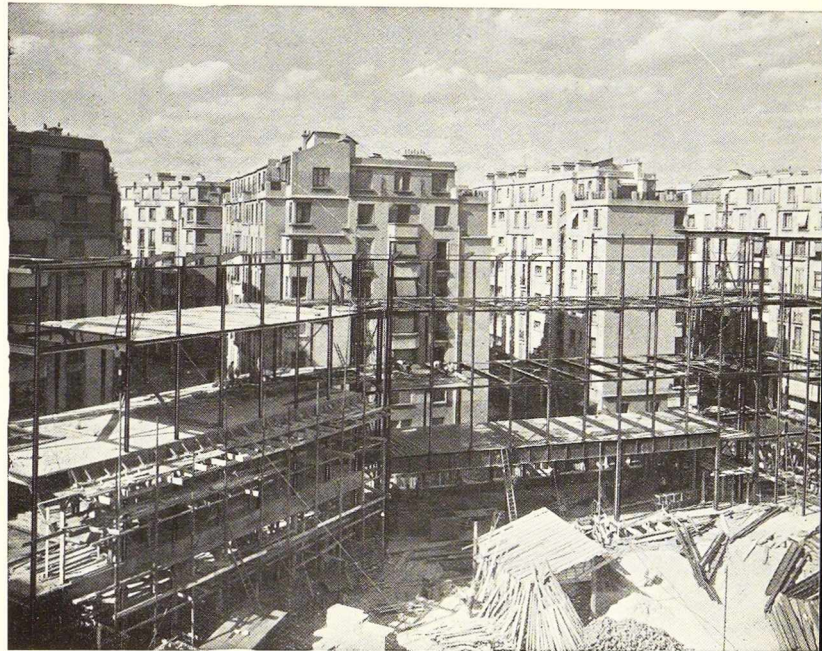
Fig. 90. Vue d'ensemble de l'ossature en cours de montage.
