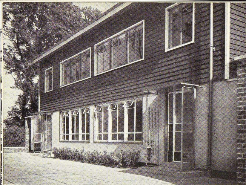
Fig. 120. Façade de la maison B. Au rez-de-chaussée, revêtement en tôle pliée en queue d'aronde recouverte d'un enduit, au premier étage, tôle à clins horizontaux.
