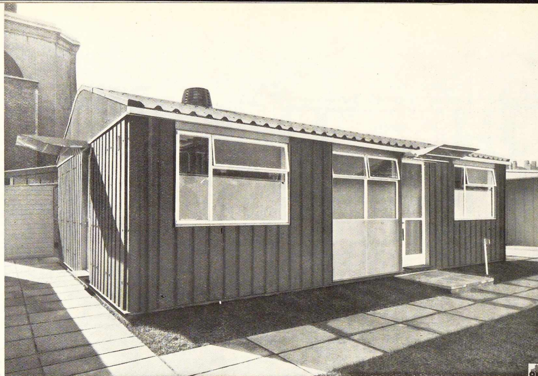
Fig. 131. Vue générale de la maison Arcon.
