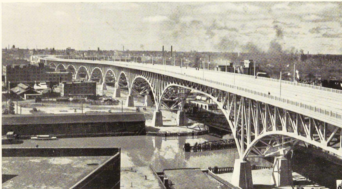
Fig. 15. Vue générale du Main Avenue Bridge à Cleveland (U.S.A.).
