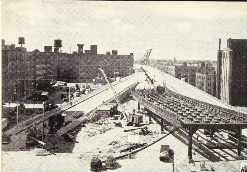
Fig. 19. Viaduc d'approche côté Est.
