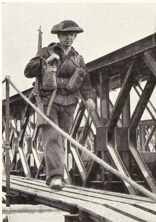
Fig. 69. Pont Bailey de 2 fois 2 maîtresses poutres. On note la construction entièrement soudée et la passerelle en porte-à-faux.
