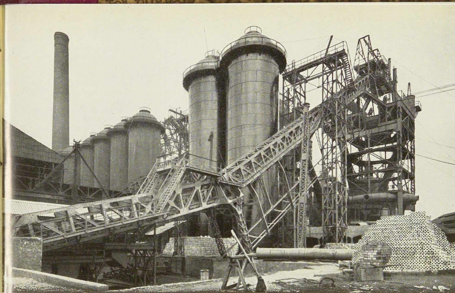
CHARPENTE DE HAUT FOURNEAU ET APPAREILS COWPER EN MONTAGE AUX USINES GUSTAVE BOËL A LA LOUVIÈRE
