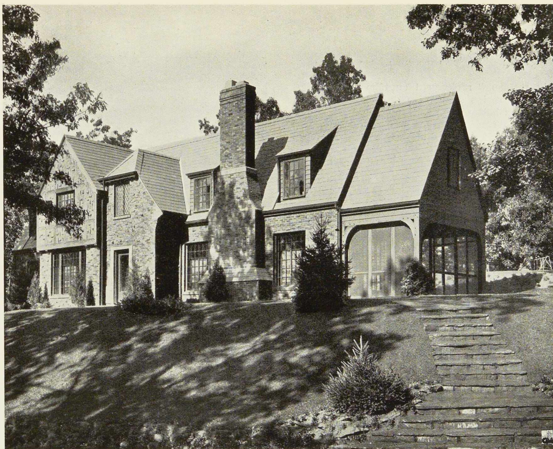
Fig. 197. Une villa, œuvre de l'architecte Victor Nurmi, réalisée en ossature Stran-Steel.
