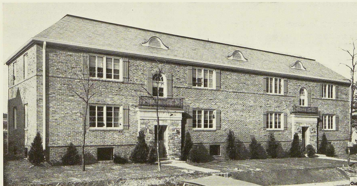
Fig. 205. Bloc de huit appartements érigés à Arlington dans l'Etat de Virginie, suivant les plans de l'architecte A. F. Thelander. Les murs extérieurs, les planchers et plafonds et les cloisons intérieures sont en panneaux standard Harnischfeger.
