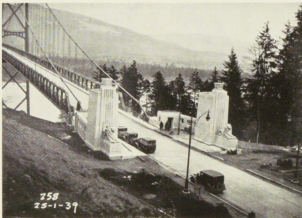
Fig. 177. Entrée Sud du pont de Lions' Gate situé dans une des plus belles régions de la Colombie britannique.
