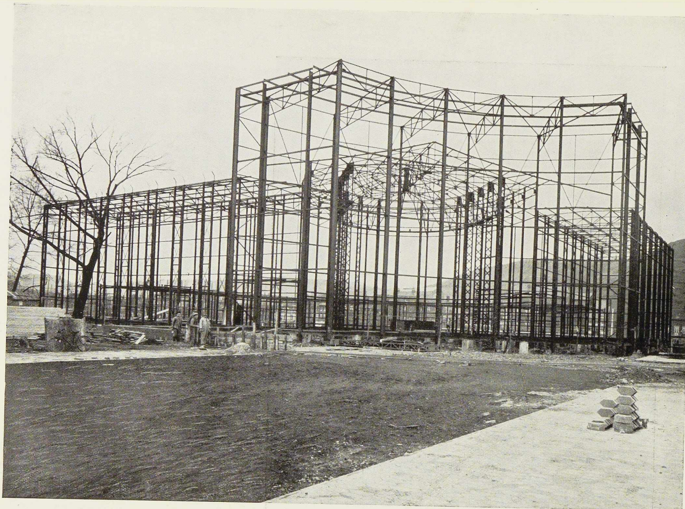
Ossature métallique du Palais du Commissariat Général de l'Exposition Internationale de l'Eau Liège 1939.
