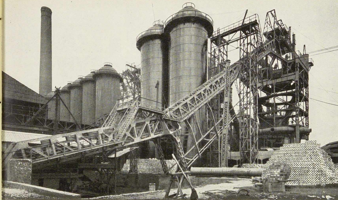
CHARPENTE DE HAUT FOURNEAU ET APPAREILS COWPER EN MONTAGE AUX USINES GUSTAVE BOËL A LA LOUVIÈRE
