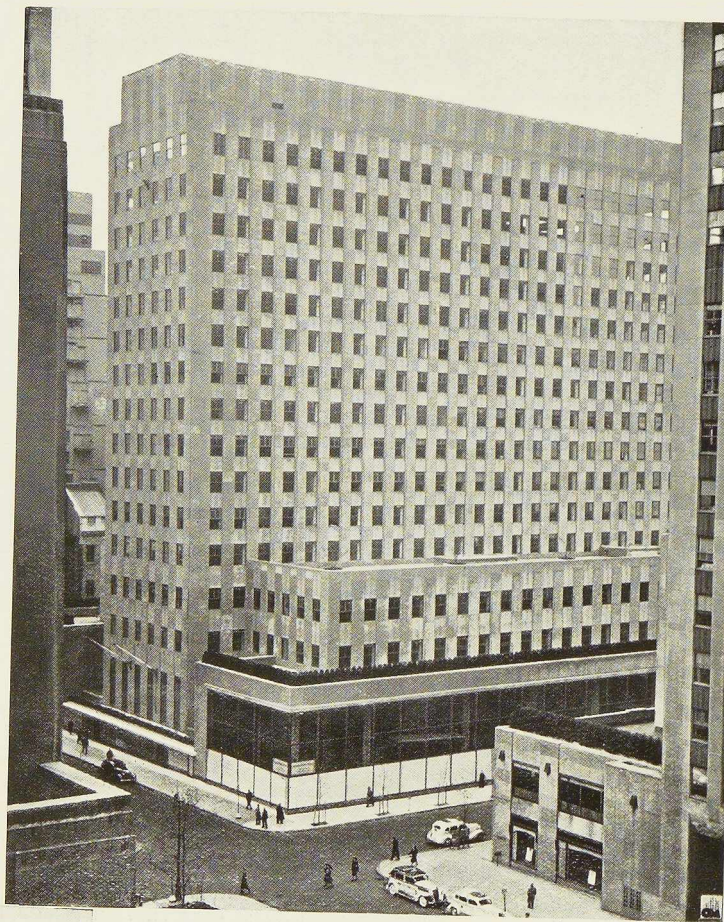
Fig. 135. Vue de la Holland House, dernier bâtiment du Rockefeller Center à New-York. L'ossature de ce gratte-ciel est en acier.
