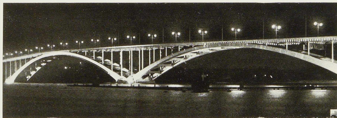
Fig. 503. Vue d'ensemble prise la nuit du pont de l'Ouest (Västerbron) à Stockholm, réalisé en 1935. Type de pont en arc simple surbaissé.
