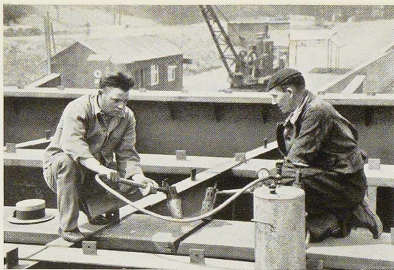
Fig. 487. Préchauffage d'un joint en V avant soudure.
