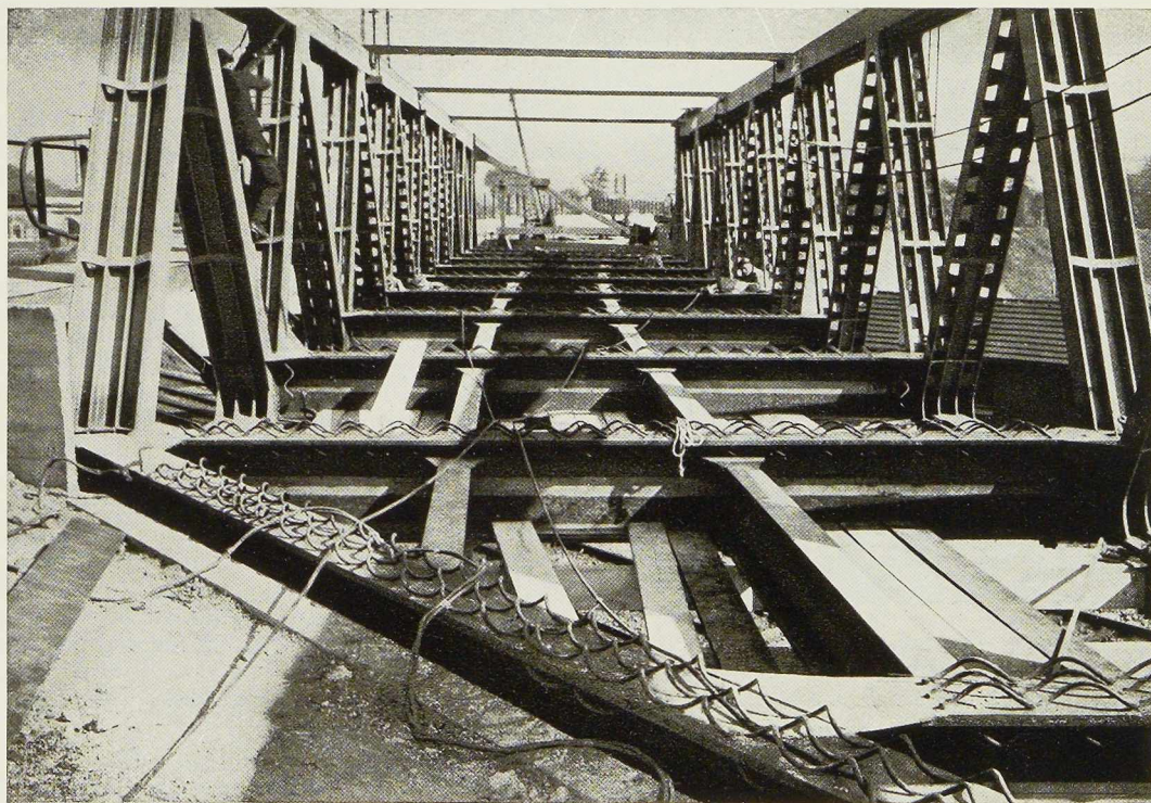
Fig. 548. Mise en place des spires alpha avant le bétonnage de la dalle.
