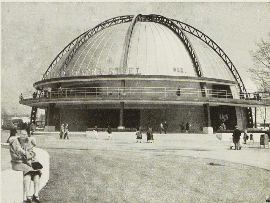
Fig. 554. Vue de l'important pavillon de la Compagnie United States Steel à l'Exposition de New-York. Le pavillon est recouvert d'un dôme en acier inoxydable de 40 mètres de diamètre.
