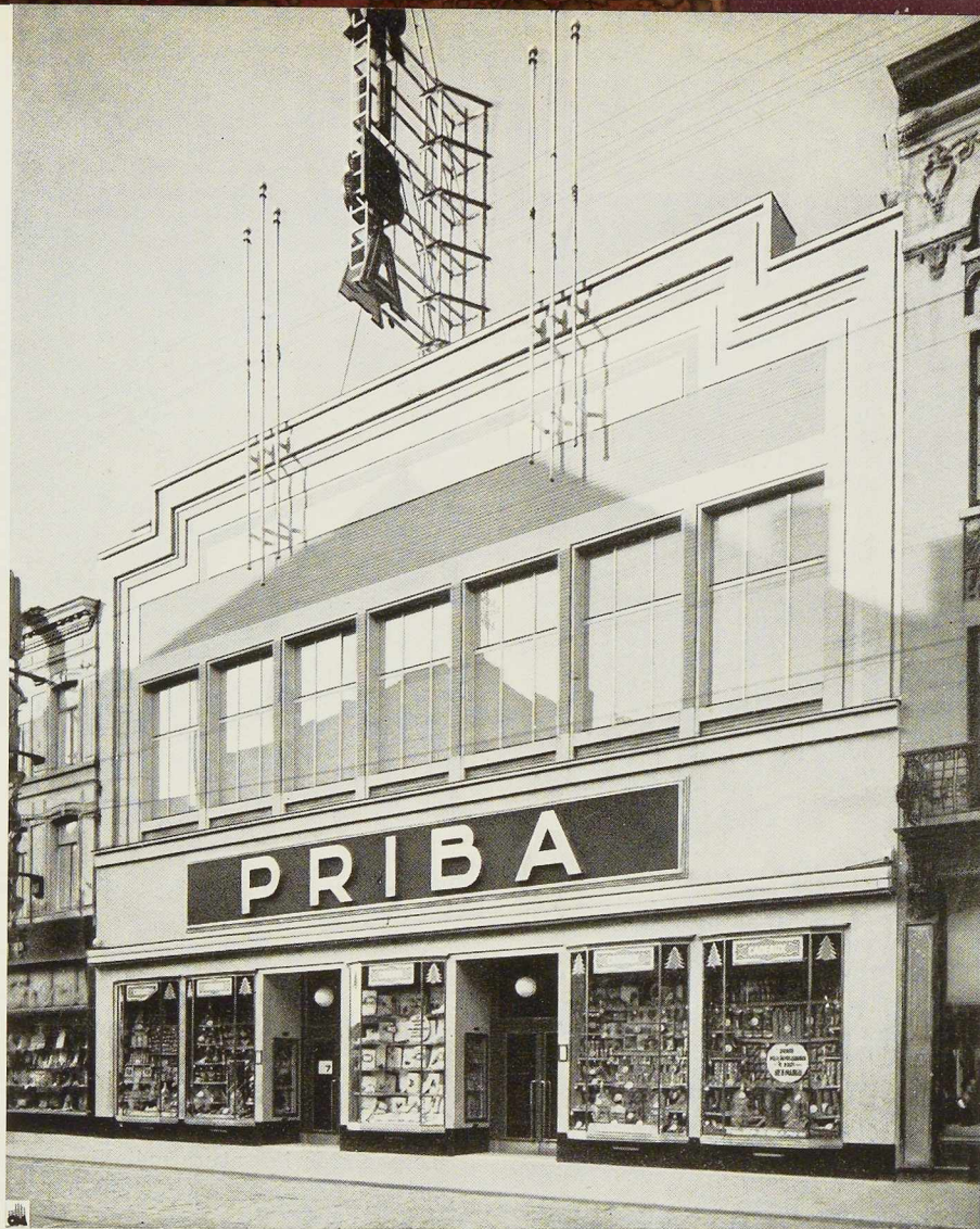
Fig. 518. Vue générale des nouveaux magasins « Priba » à La Louvière.
