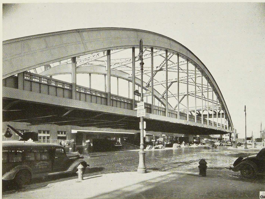
Fig. 553. Pont en arc métallique de 110 mètres de portée passant au-dessus de Canal Street à New-York. Ce pont fait partie de la chaussée surélevée West Side Highway.
