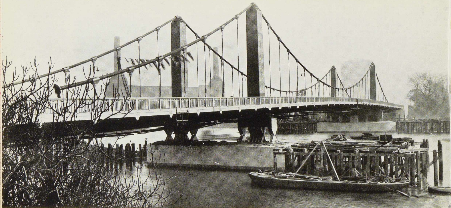
Fig. 509. Pont de Chelsea en Angleterre. Vue générale. On remarque l'absence de traverses à la partie supérieure des pylônes, qui sont entièrement isolés.
