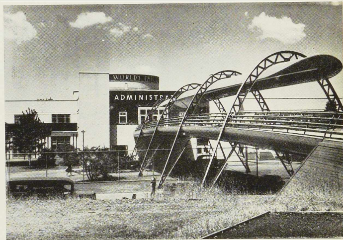
Fig. 461. Le « Pont de demain ». Cet ouvrage métallique, établi au-dessus d'une chaussée à grand trafic, conduit les piétons au bâtiment de l'Administration de l'Exposition.
