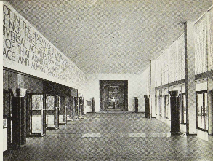
Fig. 469. Vue du grand hall d'honneur du pavillon belge.
