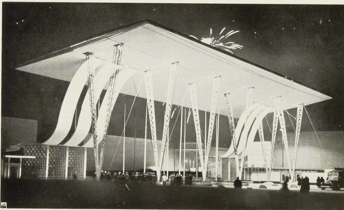
Fig. 414. L'entrée Bressoux sur la rive droite est constituée par une sorte d'aile d'avion soutenue à grande hauteur par six portiques en V.
