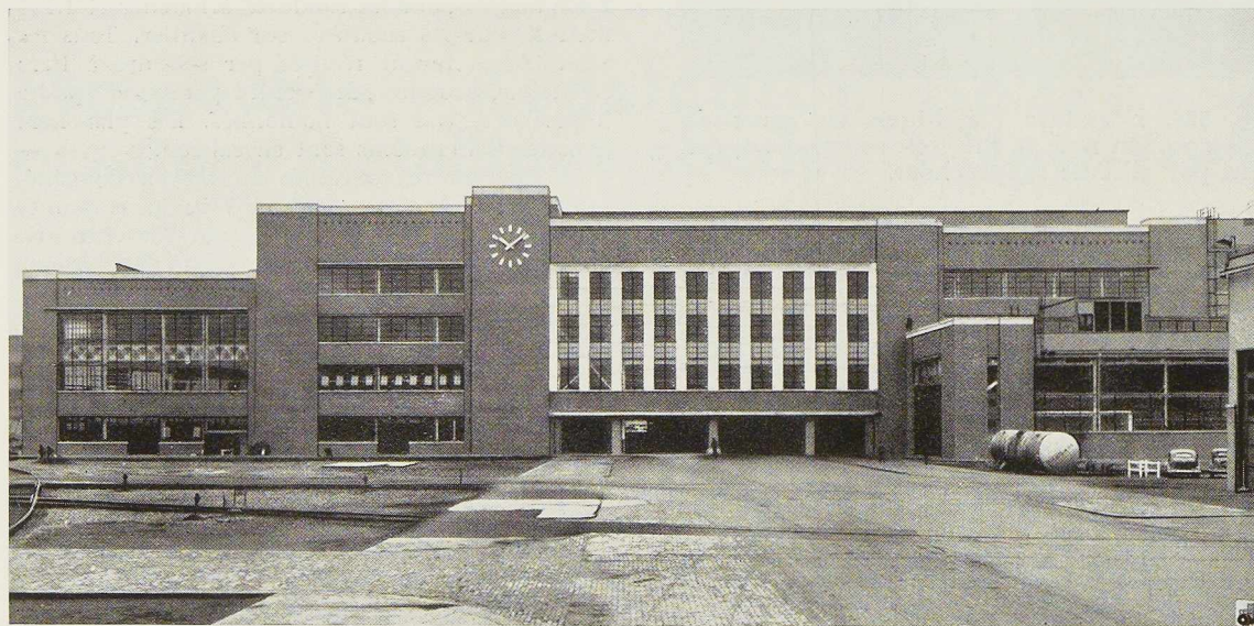
Fig. 388. Façade des nouveaux ateliers de la Ford Motor Company à River Rouge (E.-U.).
