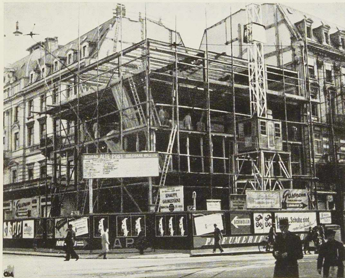
Fig. 394. Vue prise au cours des travaux. L'ossature en acier est presque complètement achevée.
