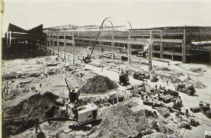
Fig. 390. L'ossature métallique des nouveaux ateliers. Vue prise en cours de montage.
