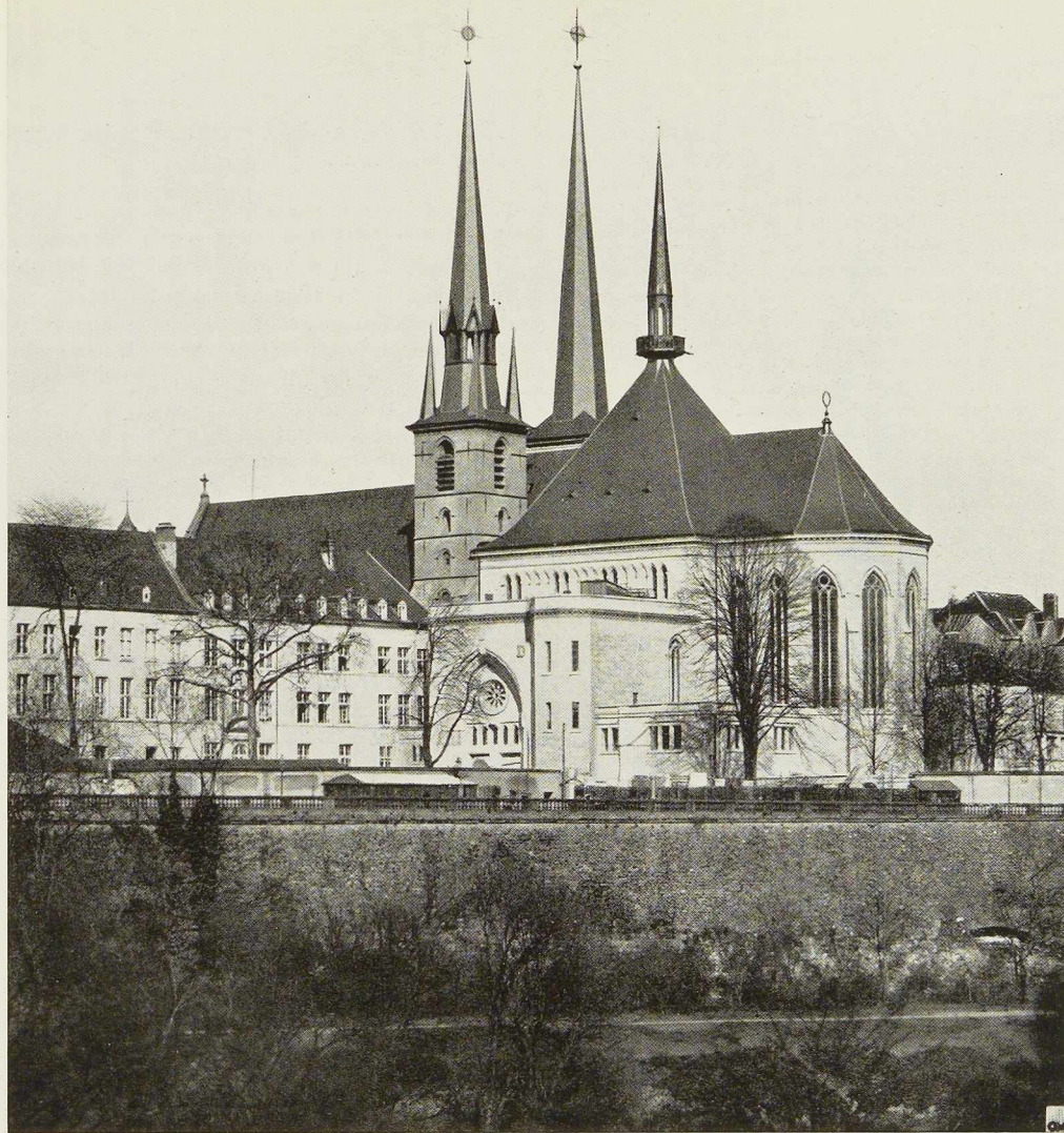
Fig. 366. Vue d'ensemble de la Cathédrale de Luxembourg après les travaux d'agrandissement.
