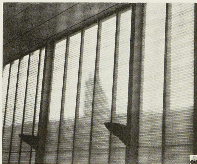
Fig. 365. Vue intérieure d'une des façades vitrées. On note le projecteur assurant l'éclairage indirect de la salle.
