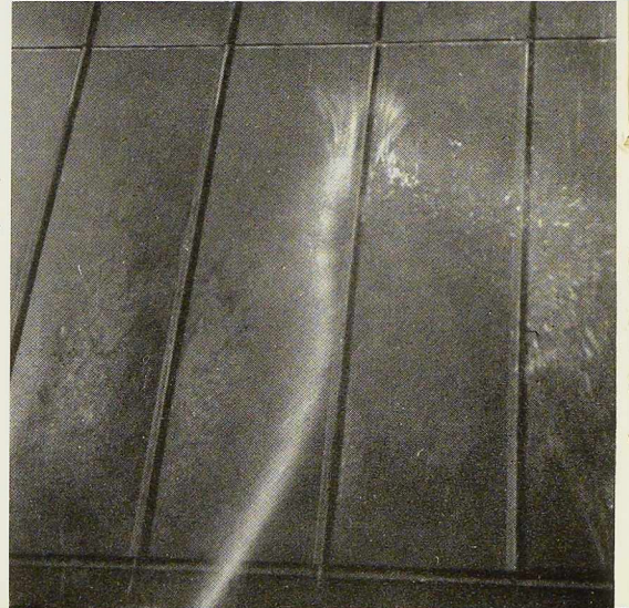
Fig. 357. Les joints sont rendus étanches grâce à de l'asphalte, leur étanchéité a été mise à l'épreuve au moyen d'une lance de pompier.
