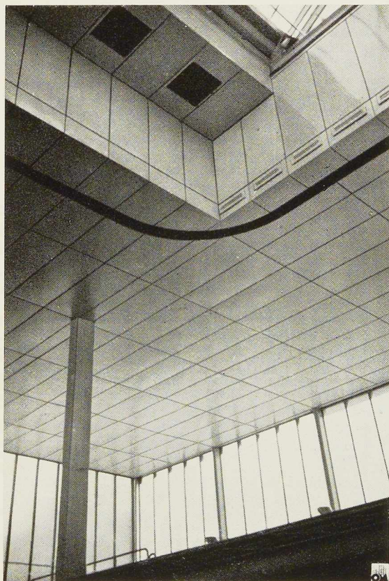
Fig. 363. Un détail de la grande salle achevée. Tous les panneaux du plafond, peints en jaune, sont enlevables pour inspection des canalisations. On note les hublots carrés destinés à assurer l'éclairage de la salle de cinéma, lorsque le toit mobile, muni des réflecteurs, est ouvert. Notez également la fente réservée pour le passage de la cloison mobile.
