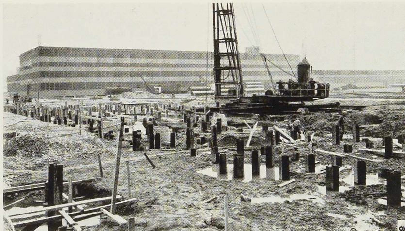
Fig. 389. Vue du chantier pendant le battage des pieux en poutrelles H.
