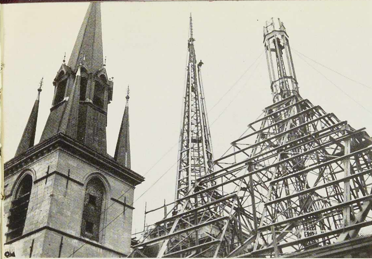
Fig. 373. Montage de la charpente à l'aide d'un mât métallique placé à l'intérieur de la charpente.
