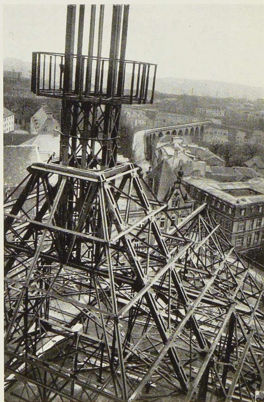
Fig. 368. Fermes principales de la nouvelle nef et de la flèche.
