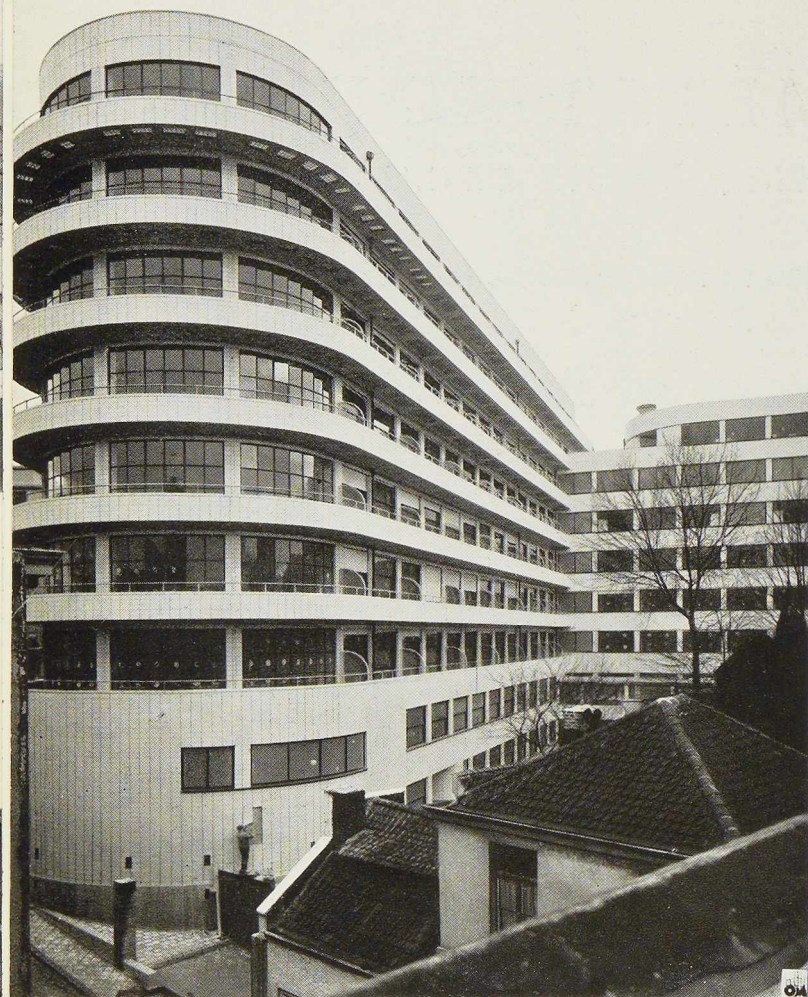
Fig. 265. L'extrémité en rotonde de l'aile d'hospitalisation du Centre Universitaire des Tumeurs.
