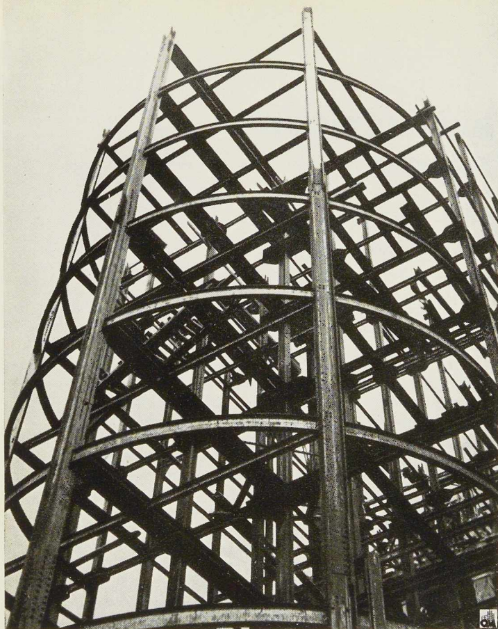
Fig. 275. Vue de l'ossature métallique de la rotonde.
