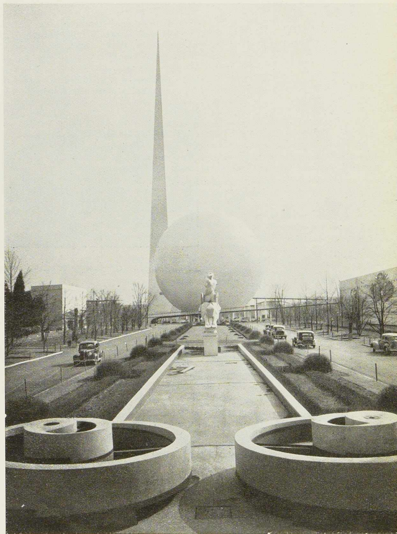
Fig. 328. Vue du pylône de 212 mètres de hauteur et de la sphère de 60 mètres de diamètre symbolisant le thème de l'Exposition : « La ville future ». Ces deux ouvrages sont construits en ossature métallique.
