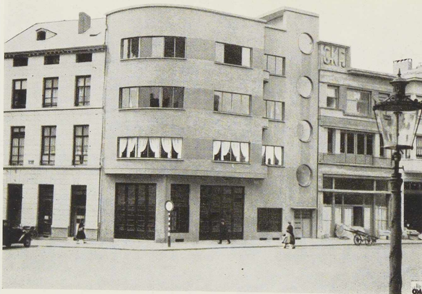
Fig. 334. Façade principale de l'immeuble.
