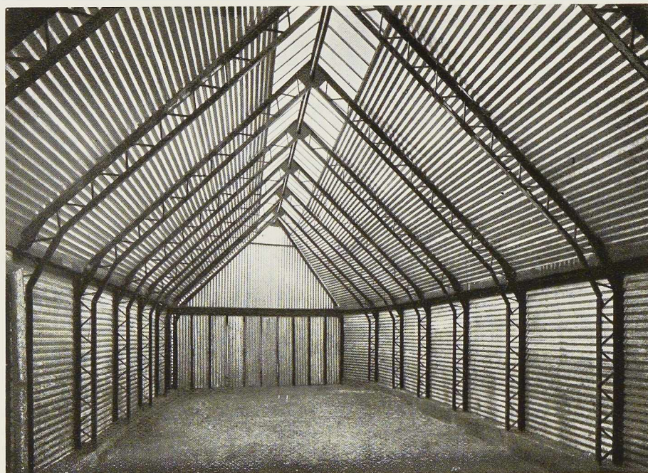
Fig. 303. Couverture légère avec fermes à treillis en barres soudées.
