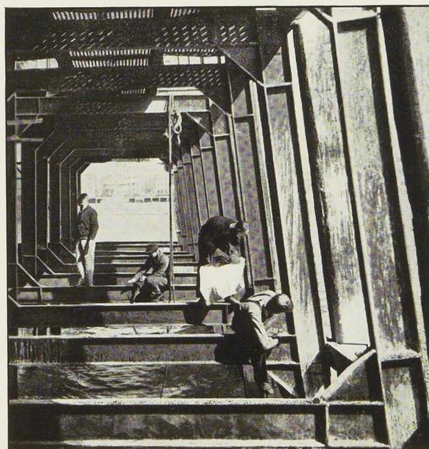
**Fig. 240.** Vue partielle du nouveau pier à ossature métallique soudée. Noter l'absence du contreventement diagonal.
