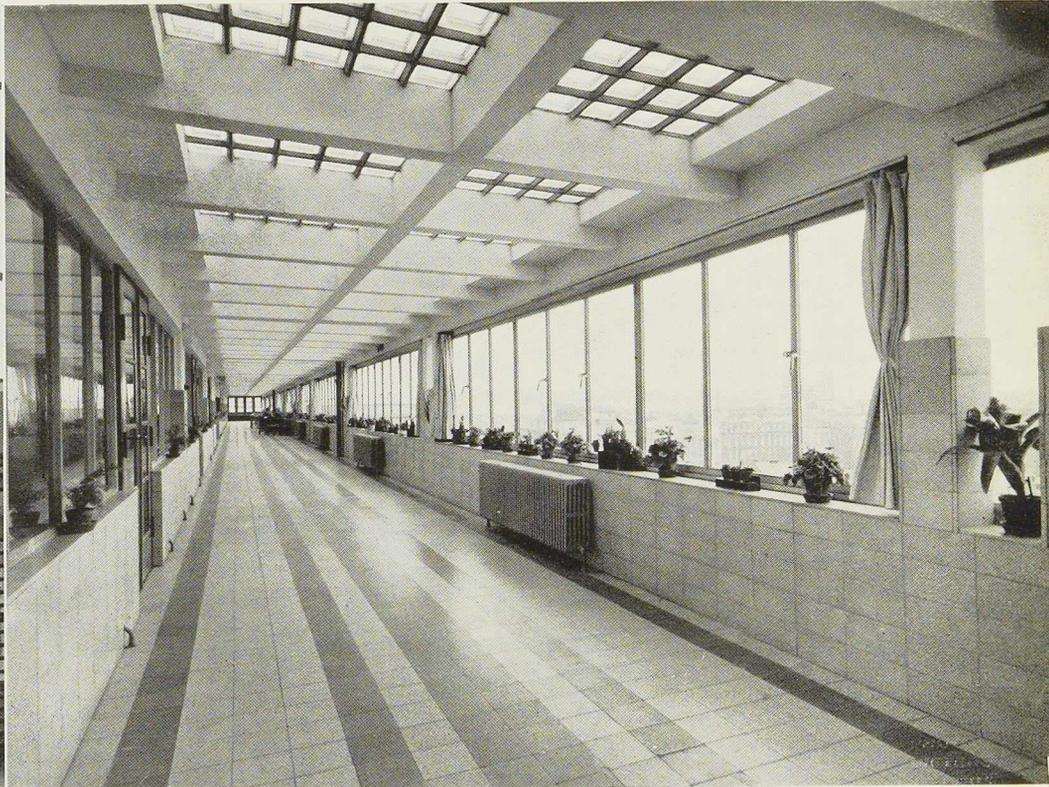
**Fig. 223** (à gauche). Le hall d'honneur. Les verrières sont démontables en quelques instants et peuvent laisser passer des voitures.
